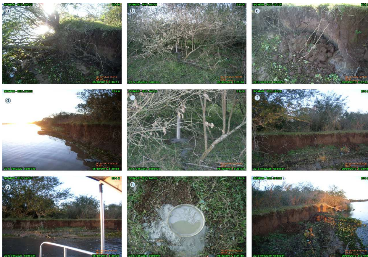
Figura 47. Aspectos da margem e da Instalação do Marco E14 A localizado na Ilha do Araújo, margem esquerda do rio; (a) margem para montante com erosão do talude e queda de árvore; (b) vista do local de instalação do marco; (c) acúmulo de material erodido no pé do talude; (d) margem para montante; (e) local de instalação do marco; (f) vista do talude; (g) vista da margem; (h) marco concretado; (i) margem/talude para jusante com acúmulo de material erodido da margem/talude.
