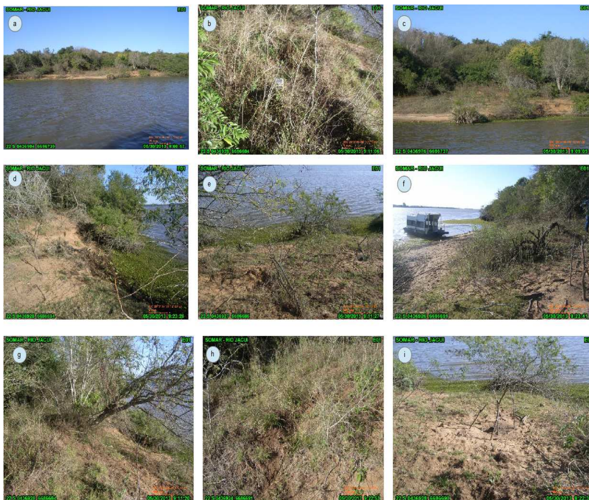
Figura 5. Marco E01 localizado na margem direita do rio Jacuí, município de Charqueadas. (a) vista da margem; (b) vista do marco para montante; (c) detalhe da margem local do marco; (d) vista do talude para montante; (e) vista da praia e do talude; (f) vista da margem para jusante; (g) árvore sendo derrubada pela erosão para montante; (h) vegetação arbórea típica na área; (i) ação antrópica na praia.
