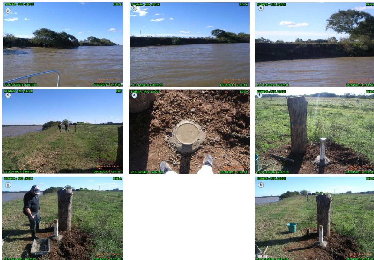
Figura 23. Marco E06 A localizado na margem esquerda do rio Jacuí, ilha da Paciência. (a) vista da margem; (b) vista da margem no local de instalação do marco; (c) detalhe do talude; (d) vista da margem para montante; (e) marco instalado; (f) marco e vista do interior; (g) (h) vista do marco e da margem para jusante.
