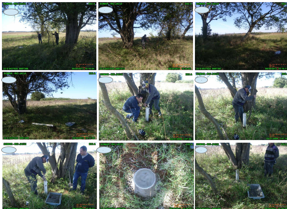
Figura 10. Marco E02 A localizado na margem esquerda do rio Jacuí, ilha da Paciência. (a) (b) (c) (d) vista do local; (e) (f) (h) (i) detalhes da fixação do marco.
