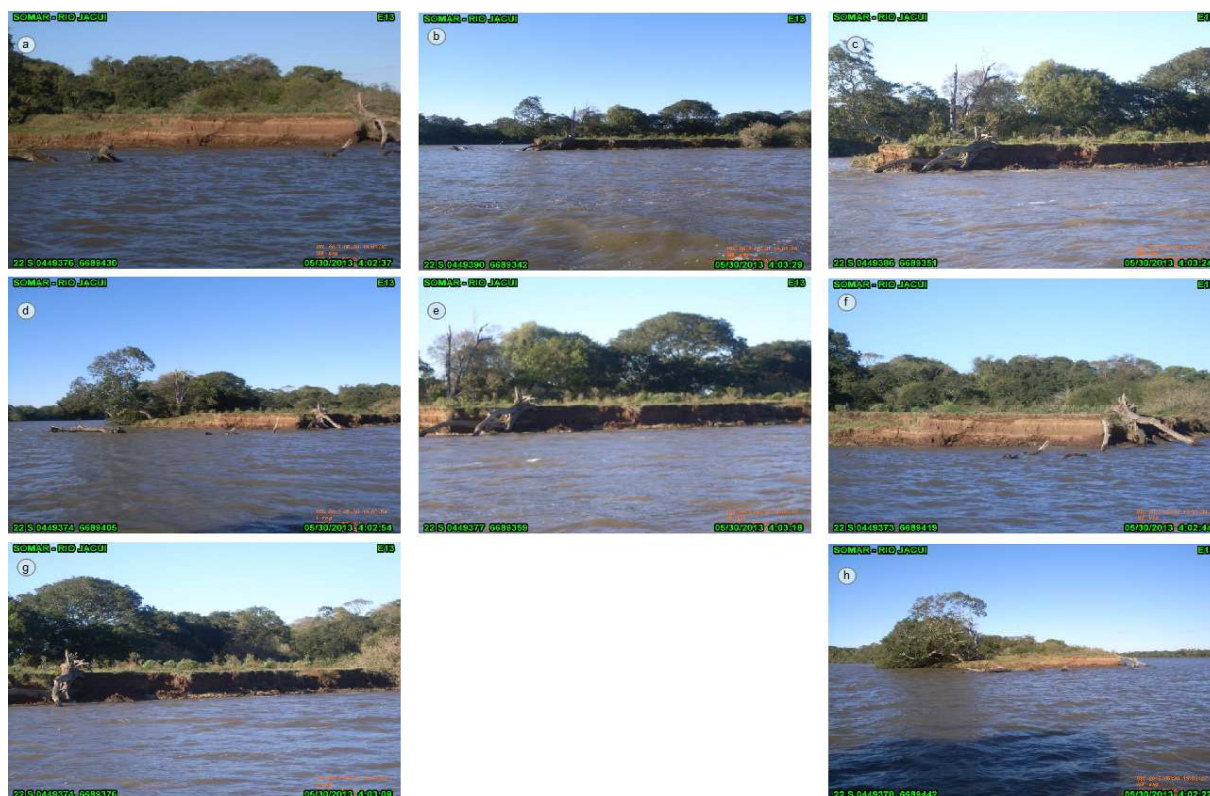
Figura 41. Outras imagens da região do marco E13 localizado na extremidade oeste da Ilha do Araújo que evidenciam processos erosivos intensos. (a) (b) (c) (d) (e) (f) (g) (h) aspectos da margem detalhes do pontal, do talude e vista da extremidade da ilha e da margem.
