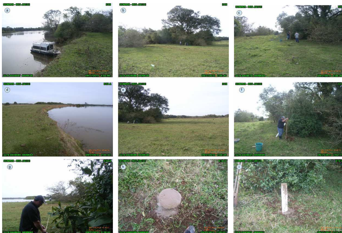
Figura 58. Marco E18 A localizado na Ilha do Fanfa. (a) vista da margem para jusante; (b) vista da área; (c) local de instalação do marco próximo da mata nativa; (d) detalhe do talude para montante; (e) vista da área para o interior; (f) instalação do marco; (g) medida da distancia do marco ao limite superior do talude; (h) (i) marco concretado.
