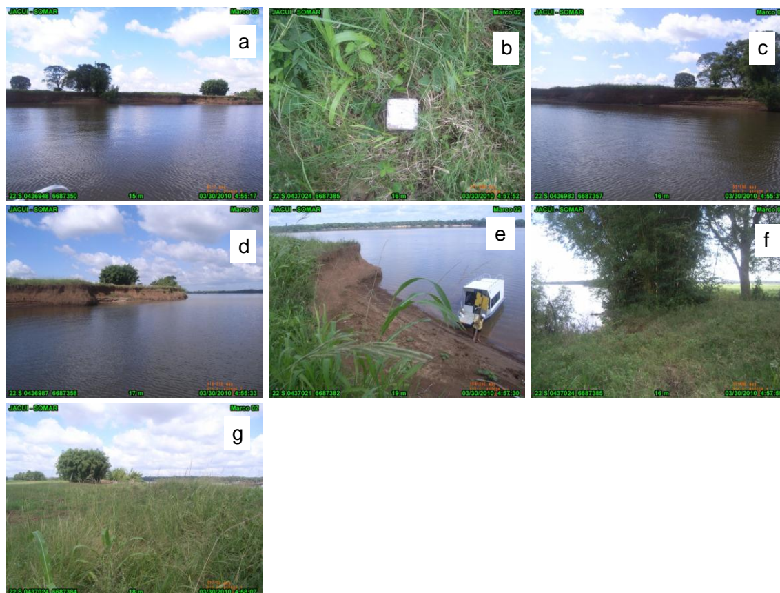
Figura 16. Marco E 02 localizado na margem esquerda do rio Jacui, ilha da Paciência. (a) vista do local; (b) marco; (c) vista da margem para montante (d) vista da margem para jusante; (e) detalhe do talude e (f) detalhe da margem para jusante e (f) vista para jusante.
