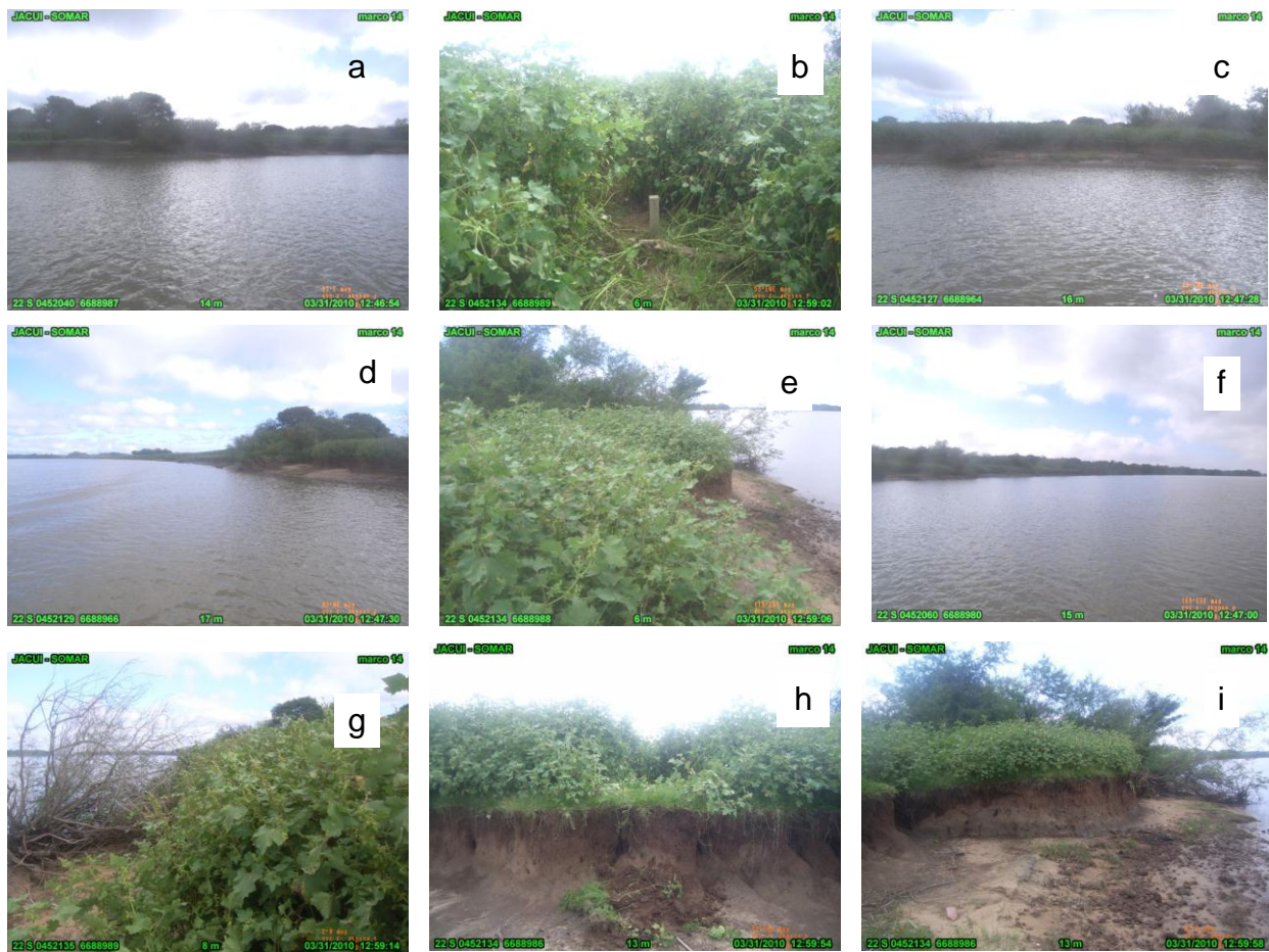
Figura 64. Marco E 14 localizado na Ilha do Araújo, margem esquerda do rio; (a) vista da margem; (b) marco; (c) vista da margem; (d) vista da margem para montante (e) vista do talude para jusante; (f) vista da margem para jusante; (g) margem para montante; (h) detalhe do talude; (i) talude para jusante.
