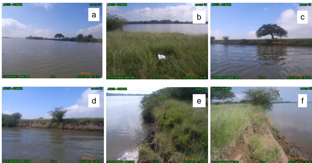
Figura 68. Marco E 15 localizado na margem direita do rio Jacui, Charqueadas (a) vista da margem; (b) marco; (c) vista em detalhe da margem; (d) vista do talude para jusante (e) detalhe da margem e talude para jusante; (f) detalhe da margem e talude para montante.
