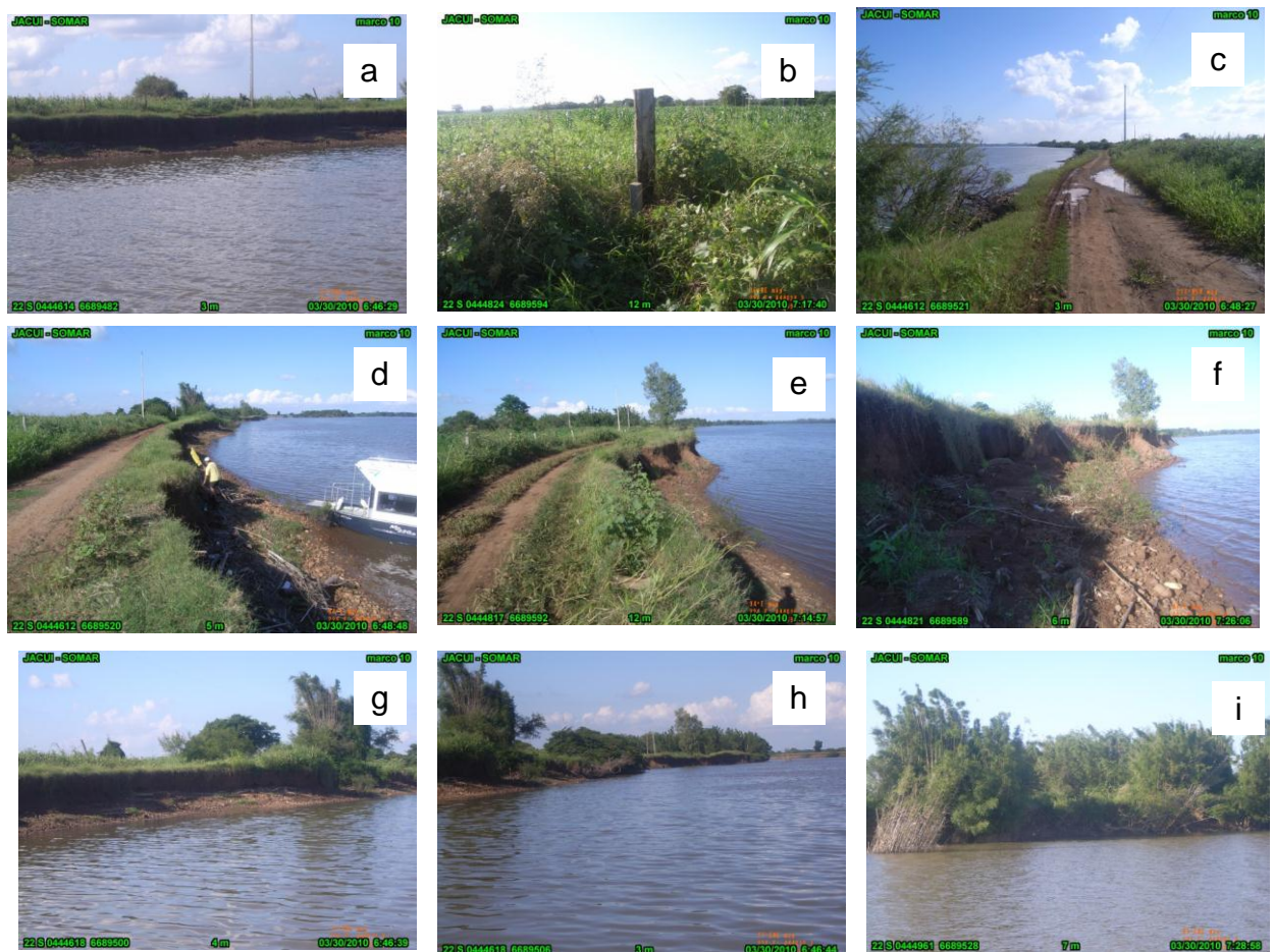
Figura 48. Marco E 10 localizado na margem esquerda do rio Jacui, Triunfo; (a) vista da margem e talude; (b) vista do marco e interior; (c) vista para montante e estrada; (d) vista do talude, estrada e seixos para jusante; (e) aspecto da margem para jusante; (f) detalhe do talude para jusante e seixos; (g) aspecto do talude para jusante; (h) aspecto da margem para jusante; (i) detalhe da margem com taquaral.
