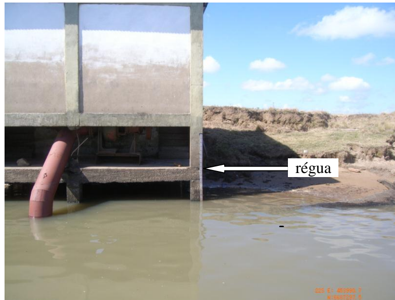
Figura 3. Régua de nível da instalada na tomada de água da Fazenda São José (FSJ), referencia DATUM vertical de Imbituba-SC.
