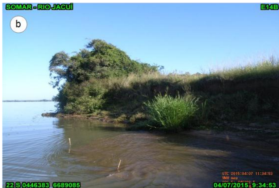
Figura 43 - Marco E14B, localizado na Ilha do Araújo, (a) marco; (b) margem e talude para montante.
