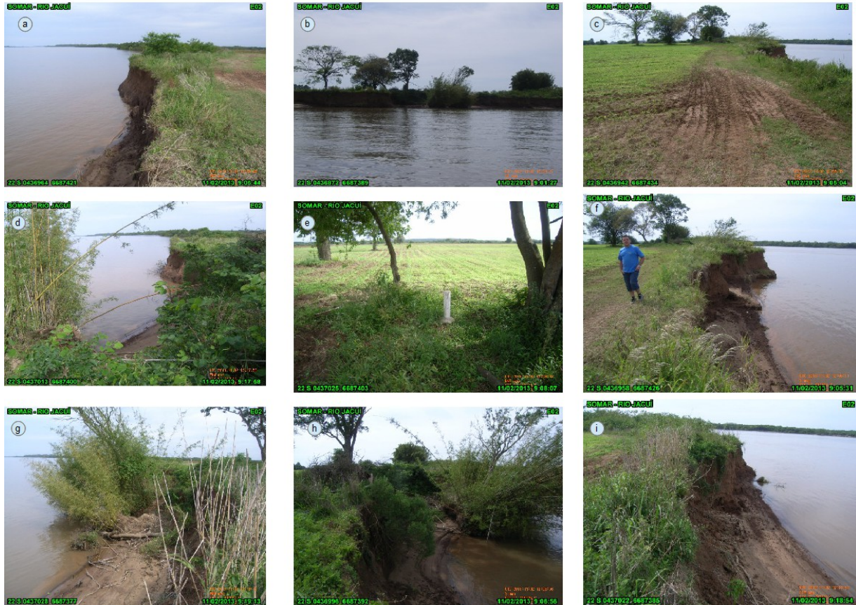
Figura 10. Imagens do Marco E02 A e imediações, localizado na margem esquerda do rio Jacuí, ilha da Paciência. (a) vista da margem para montante; (b) vista da margem; (c) vista da área para jusante; (d) detalhes do talude para montante; (e) vista do marco e interior; (f) detalhes do talude; (g) praia e bambual sendo derrubado pela erosão; (h) idem anterior; (i) detalhes do talude para jusante.
