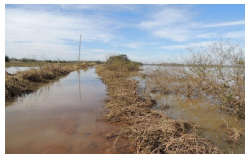
Margem esquerda do Rio Jacuí
