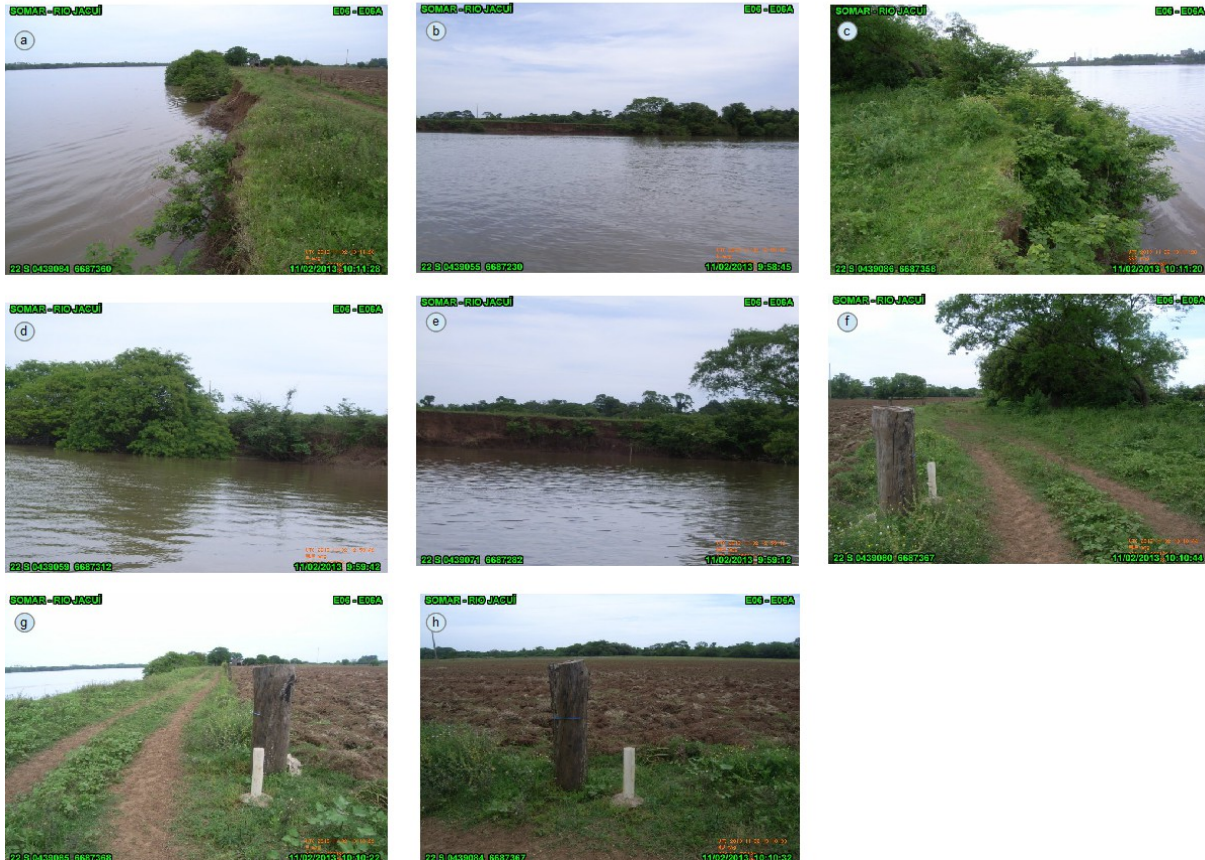
Figura 23. Imagens do Marco E06 e E06 Ae imediações localizados na margem esquerda do rio Jacuí, ilha da Paciência. (a) vista da margem para montante; (b) vista da margem; (c) detalhe da margem para jusante; (d) vista da margem para montante vegetada; (e) talude com solapamento do talude; (f) vista do marco E06 A e da margem para jusante; (g) vista do marco, cerca e estrada local para montante; (h) marco E06 A e interior arado.
