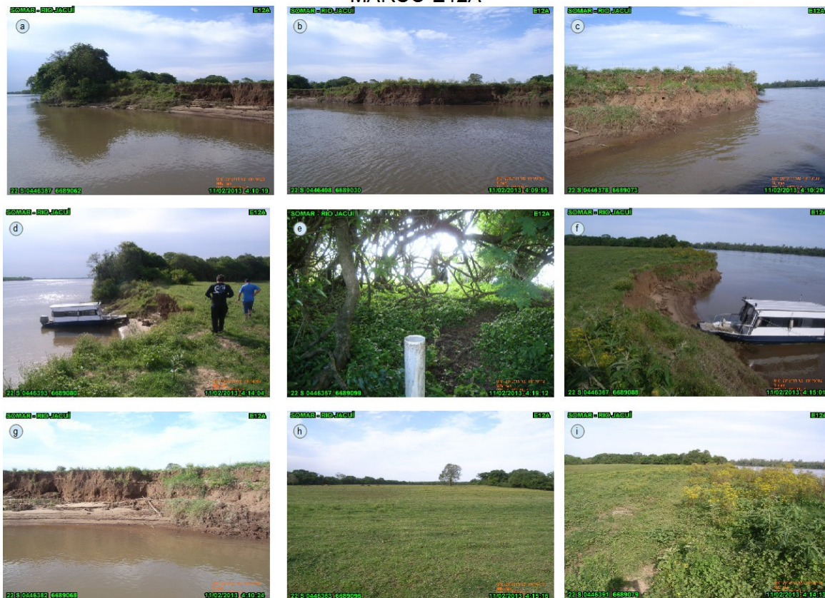
Figura 39. Imagens do Marco E12 A imediações localizado na ilha do Fanfa, margem esquerda do rio Jacuí; (a) vista da área para montante com vegetação natural ciliar ao fundo local do marco E12A; (b) vista da margem; (c) margem para jusante com solapamento do talude; (d) vista do talude e do mato para montante onde foi instalado o marco; (e) marco; (f) margem e talude para jusante; (g) detalhe do talude com a formação de degraus e material solapado; (h) vista do interior; (i) margem para jusante.
