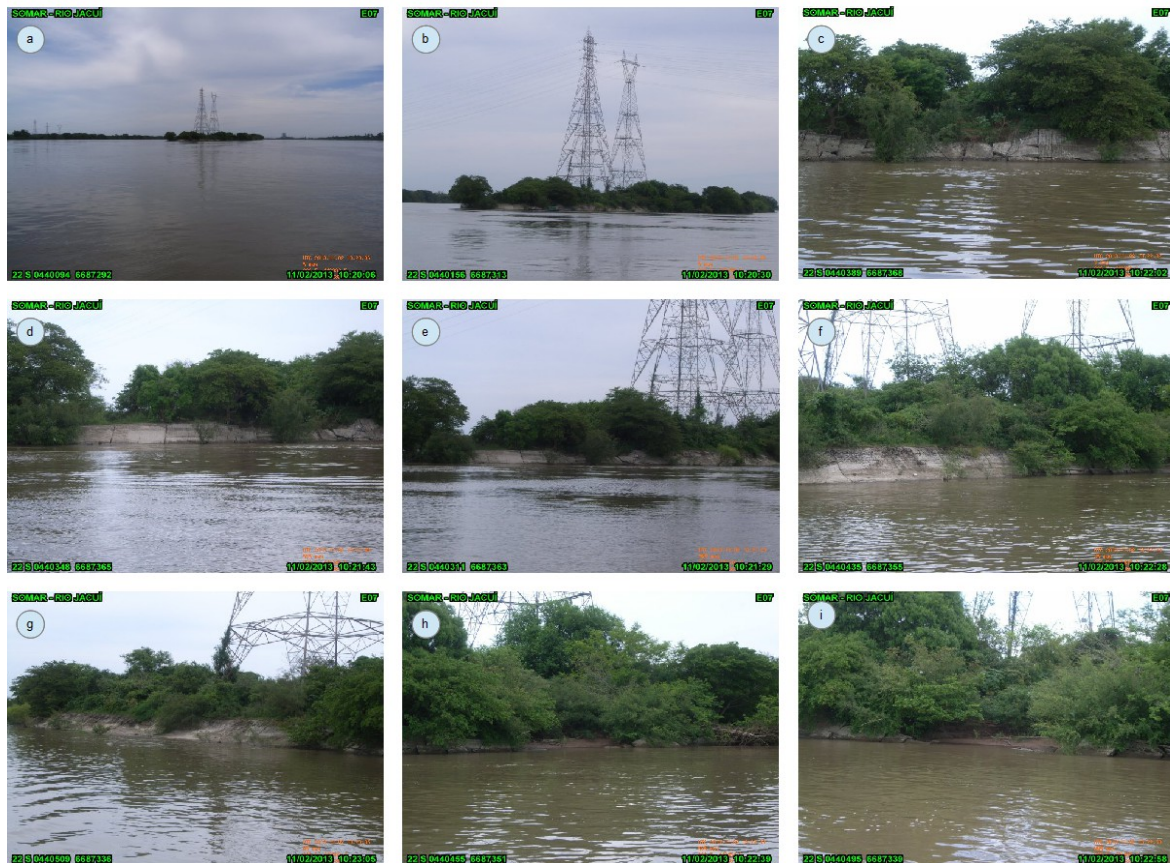
Figura 27. Imagens do pontal da ilha das Cabras e das estruturas de concreto, localizadas na margem esquerda do rio Jacuí para contenção da erosão e proteção das torres de transmissão de energia. O marco E07 encontra-se mais para jusante. (a) vista do pontal da ilha; (b) torres; (c) parede de proteção com problemas; (d) vista da proteção; (e) parede de proteção e torres; (f) idem anterior; (g) idem anterior para jusante; (h) proteção de concreto destruída e sem utilidade; (i) detalhe da área (h).
