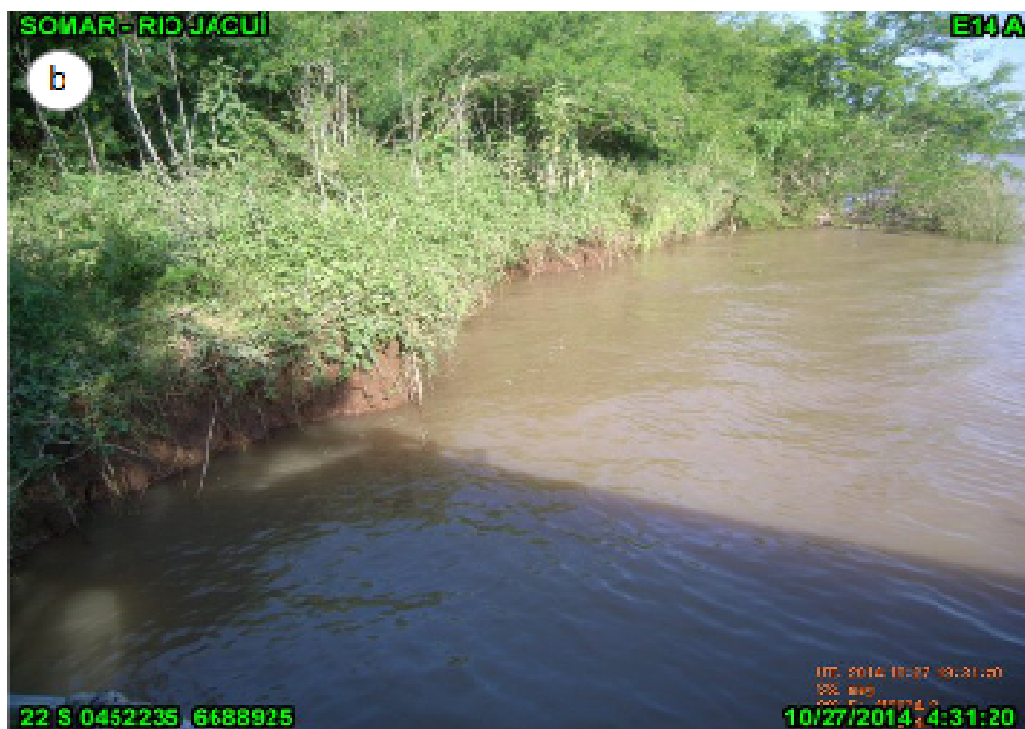
Figura 44ab. Marco E14 A , localizado na Ilha do Araújo. (a) marco; (b) talude para jusante.
