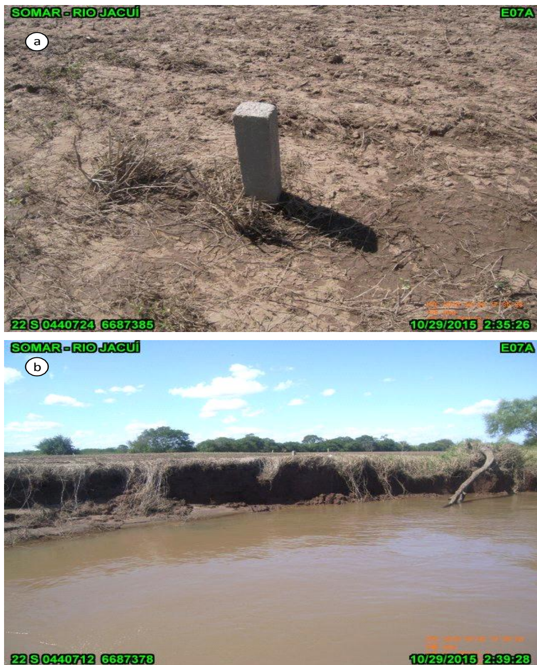
Figura 26: (ab) Marco E07A, localizado na ilha das Cabras. (a) marco; (b) marco e margem.
