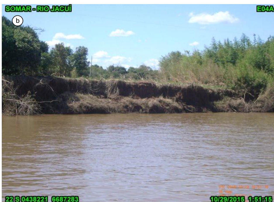
Figura 20:(ab) Marco E04A, localizado na ilha da Paciência. (a) marco; (b) margem e talude.
