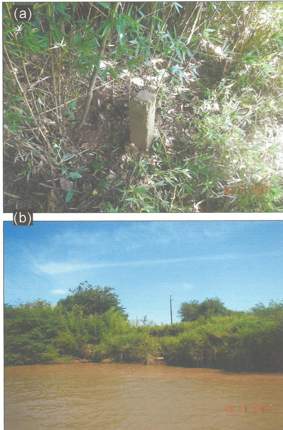
Figura 10: (ab) Detalhe do marco e vista geral do ponto de monitoramento. É possível observar que as gramíneas fixadas na face do talude estão o protegendo dos agentes erosivos.
