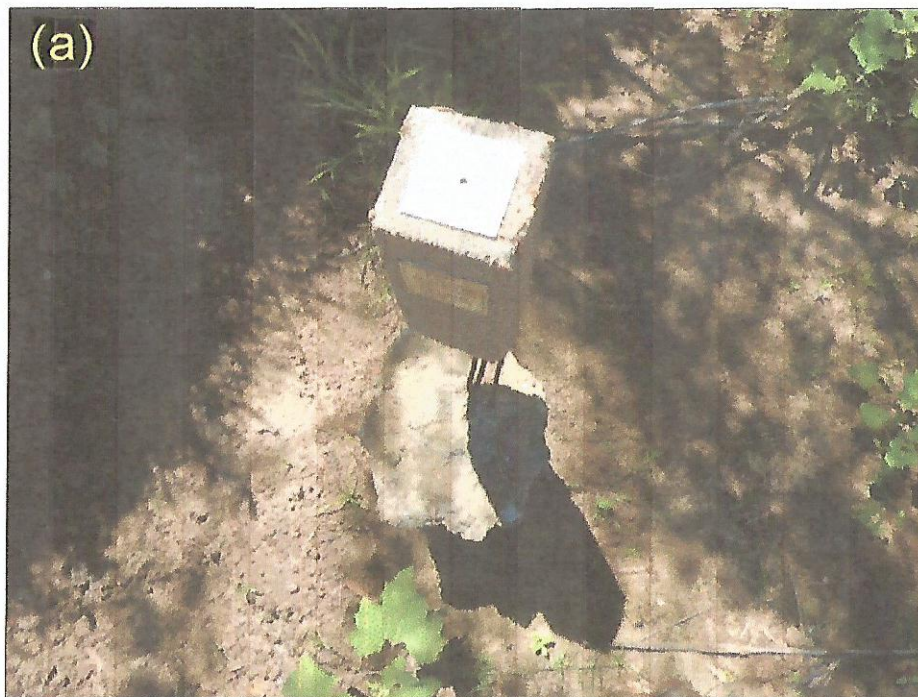
Figura 16ab: Marco E14 com sua base de concreto e ferro, tombado em uma praia da margem da ilha do Araújo.
