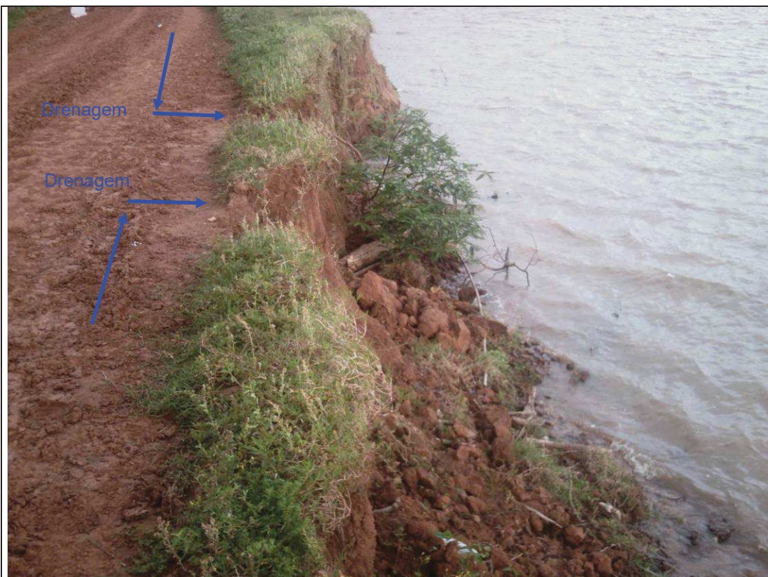
Foto 17: Drenagem natural, na estrada vicinal.
