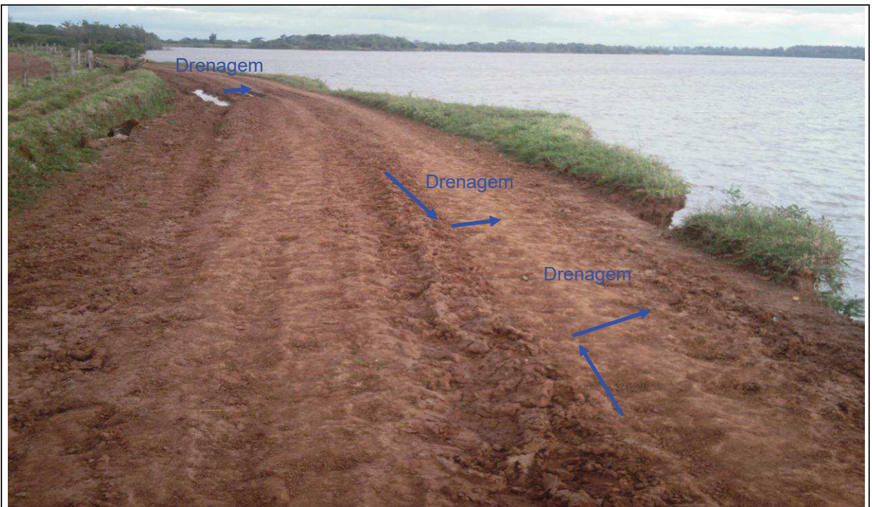
Foto 16: Vista do sentido da drenagem natural, na estrada vicinal.
