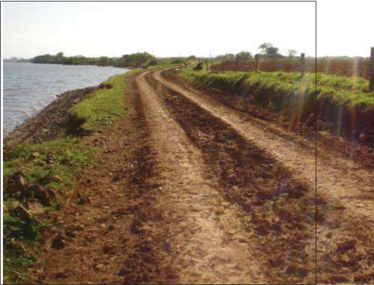
Foto 01: Estrada municipal mostrando o tipo de solo e a falta de vegetação ribeirinha (out/06).
