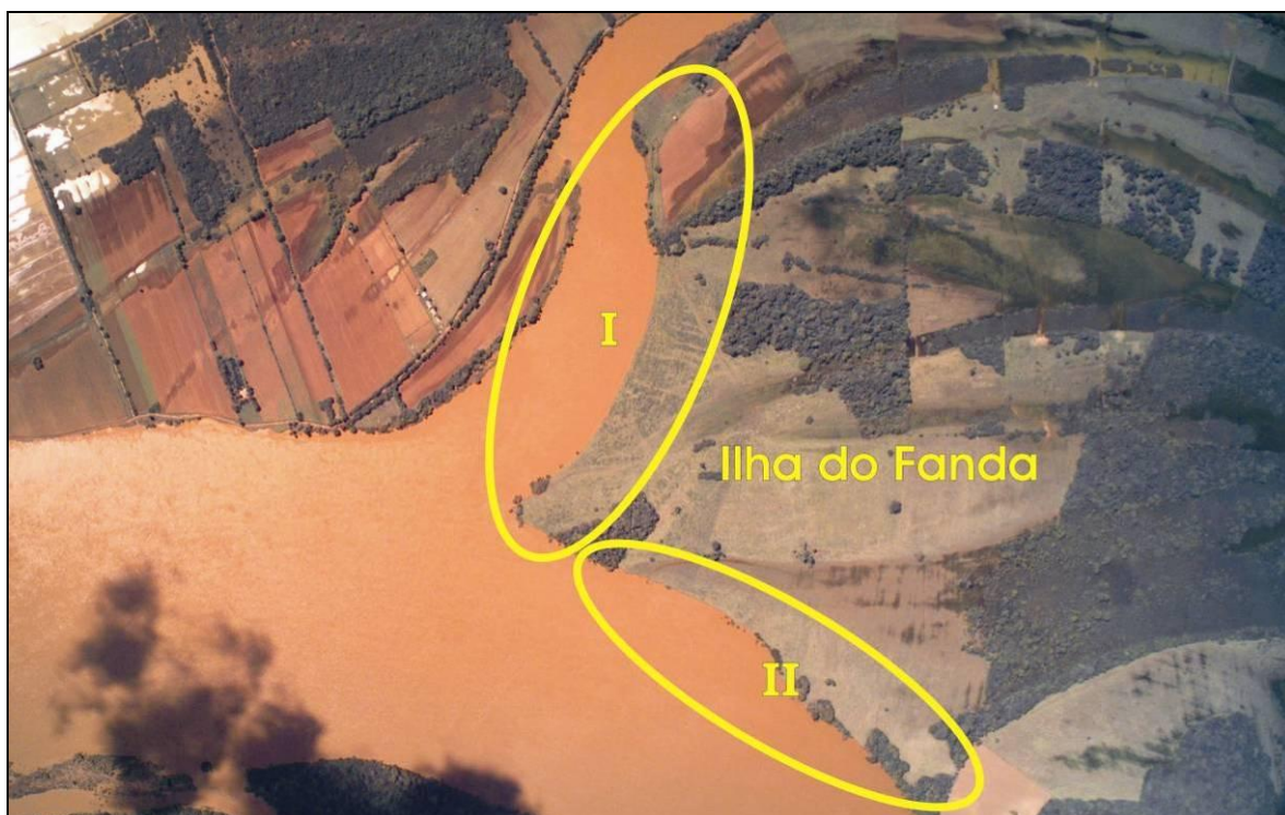
Figura 24. Foto aérea das margens erodidas na ilha do Fanfa (áreas "I" e "II").
