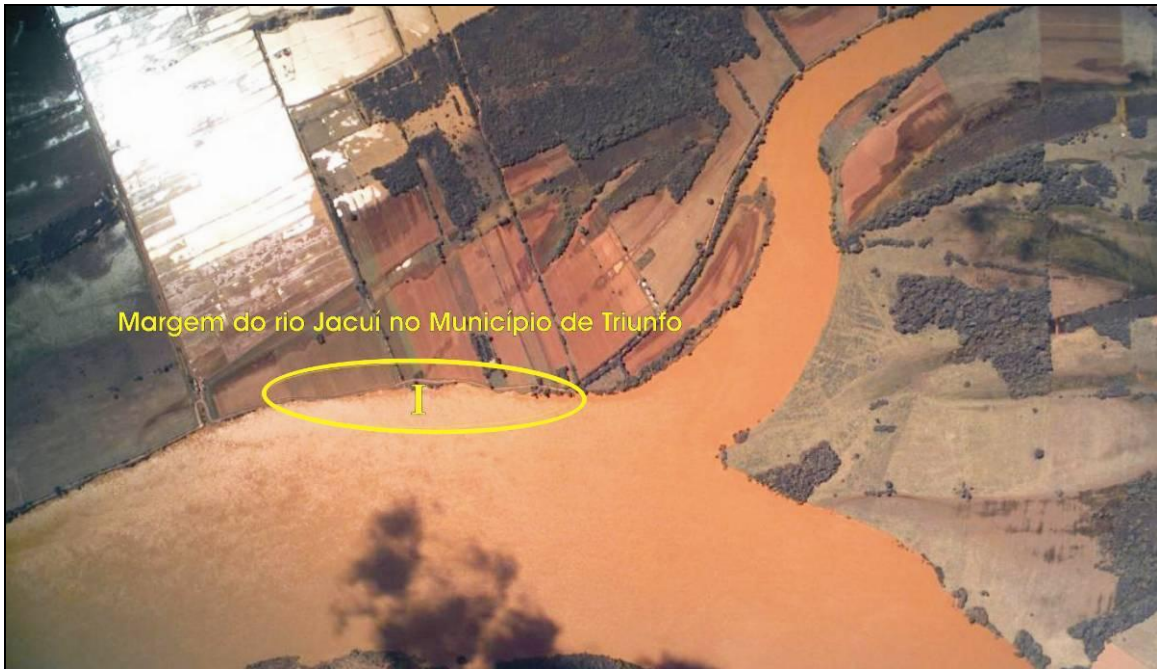
Figura 14. Foto aérea da margem erodida na margem esquerda do rio Jacuí (Ponto "I").
