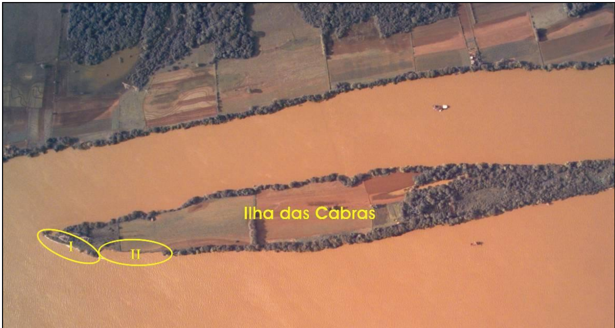
Figura 8. Foto aérea da ilha das Cabras. Na área "I" as placas de cimento aplicadas para conter a erosão da parte inicial da ilha estão comprometidas. A área "II" apresenta um talude de até 2 metros de altura.
