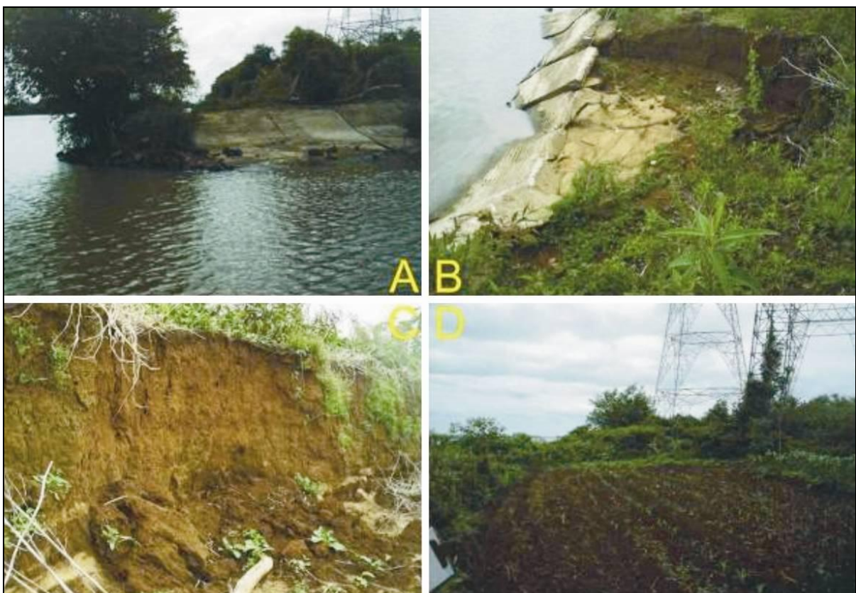
Figura 9. Problemas ambientais na ilha das Cabras. Fotos A e B: erosão da terra que da sustentação as placas de cimento. Figura C: talude de até 2 metros de altura. Figura D: cultura de milho até a margem do talude.
