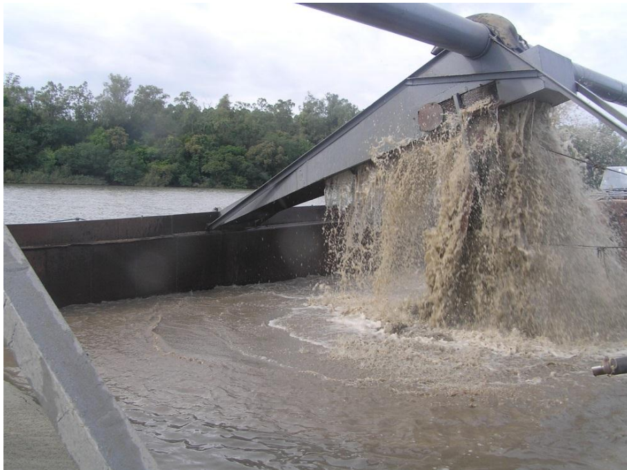
Figura 3. Fiscalização nas dragas em operação.
