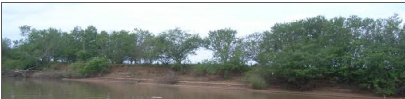
Foto 09: Linha de margem no segmento onde ocorre o desbarrancamento das margens na ilha do Dornelles, em novembro de 2011.
