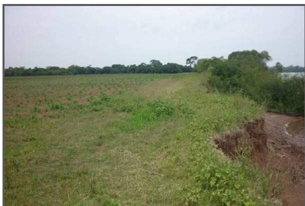
Foto 05: Segmento onde houve total supressão da mata ciliar, observando-se o barranco formado pela erosão da margem desprotegida.
