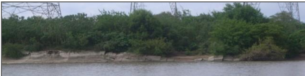
Foto 01: Linha de margem no segmento onde encontram-se as placas de concreto e as torres de alta tensão, limítrofes à área definida para o monitoramento da vegetação ciliar na ilha das Cabras, em julho de 2011.
