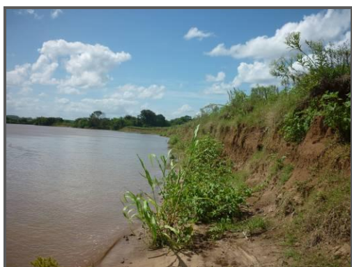
Foto 14: Segmento onde houve total supressão da mata ciliar, observando-se o barranco formado pela erosão da margem desprotegida.
