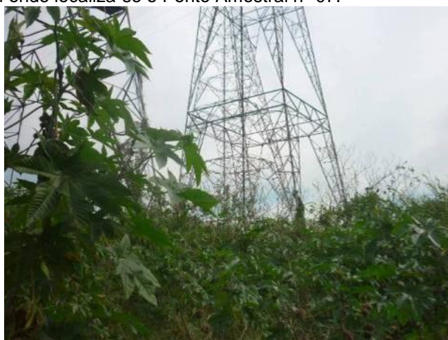
Foto 16: Ilha das Cabras. Vista de local ocupado por torre da rede elétrica, em meio à vegetação secundária.
