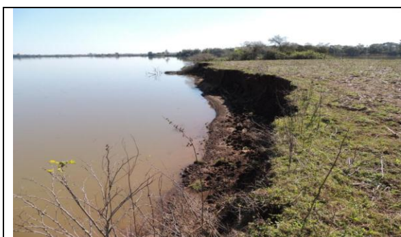
Foto 46: Detalhe do talude. Note material sendo carregado pela água.
