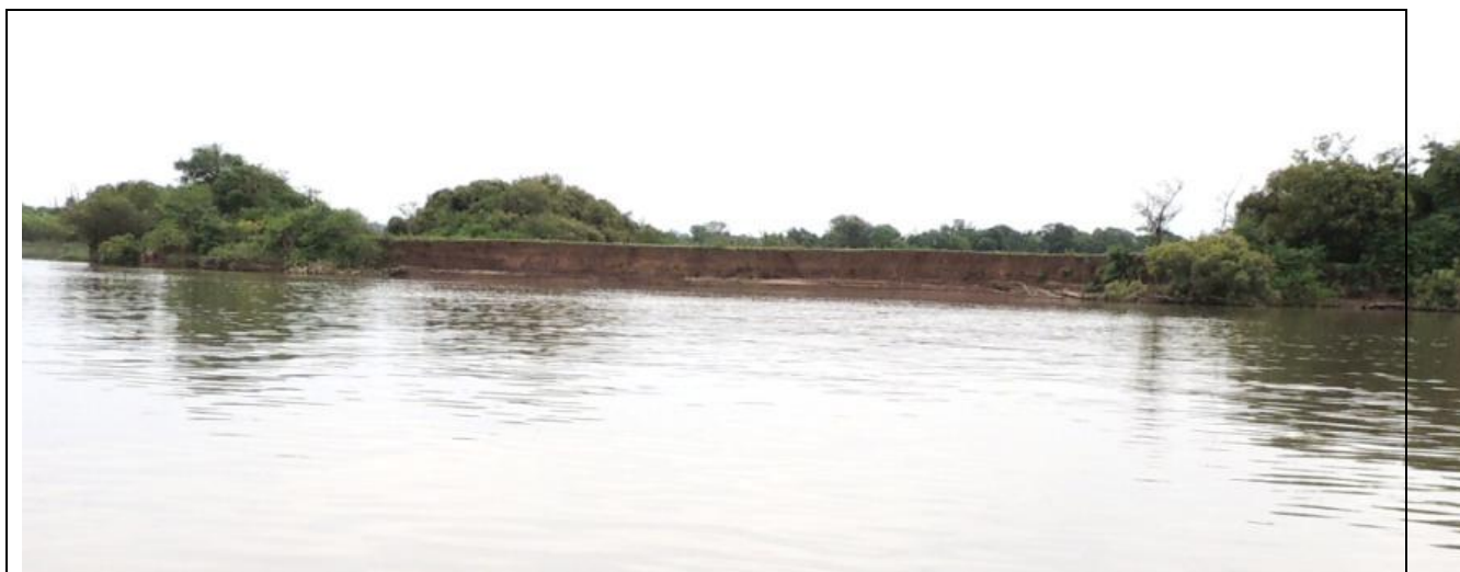
Foto 45: Vista geral do segmento de margem avaliado, em novembro de 2013.
