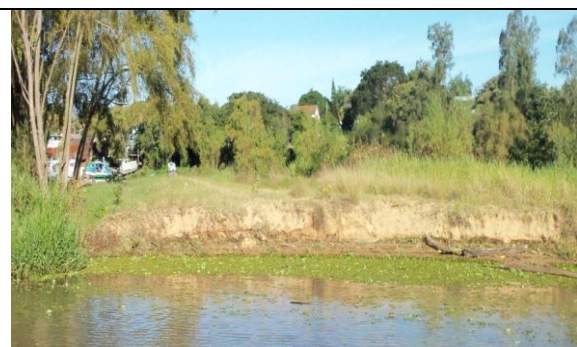
Foto 20: Talude de aproximadamente 1 metro de altura, na margem esquerda da ilha.
