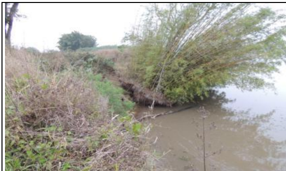
Foto 07: Touceira de Taquareira, atingida pela erosão.
