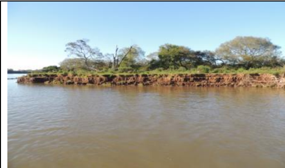
Foto 52: Vista geral do segmento de margem avaliado, em novembro de 2013.
