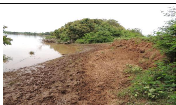
Foto 47: Detalhe da barranca, observando-se o pisoteio do gado que esta confinado na APP para preservar a lavoura.
