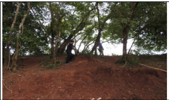
Foto 14: Detalhe do dique marginal, em local próximo ao Marco fixo.
