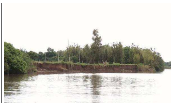
Foto 19: Vista geral da margem nas imediações do ponto de monitoramento.
