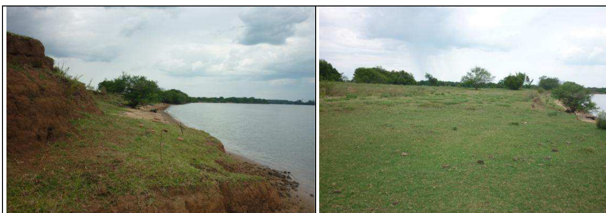
Foto 17: Detalhe do barranco destituído de vegetação protetora.
