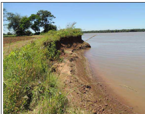
Foto 03: Vista Talude tomada a jusante do ponto amostral.
