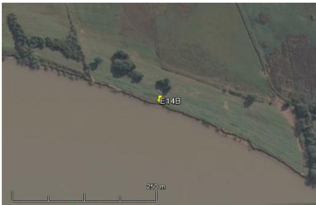
Figura 17: Imagem Google Earth, salientando o ponto amostral E14B (imagem de julho de 2016, em situação de vazão normal do rio Jacuí).
