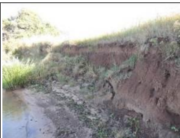
Foto 50: Detalhe do talude da margem, à montante do ponto amostral E12A.
