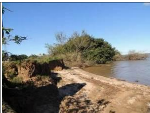
Foto 73: Detalhe do avanço da erosão à jusante do ponto E 16.
