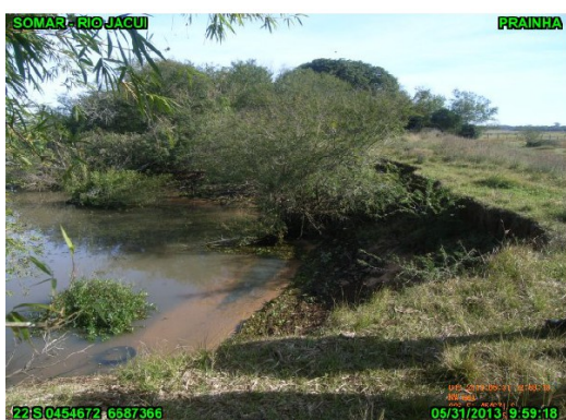
Erosão da margem/talude para montante
