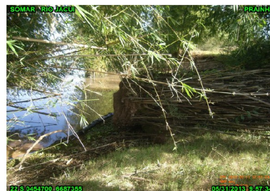
Toceira de bambu destruída
