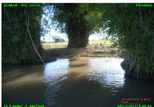
Detalhe do bambual e da erosão na base
