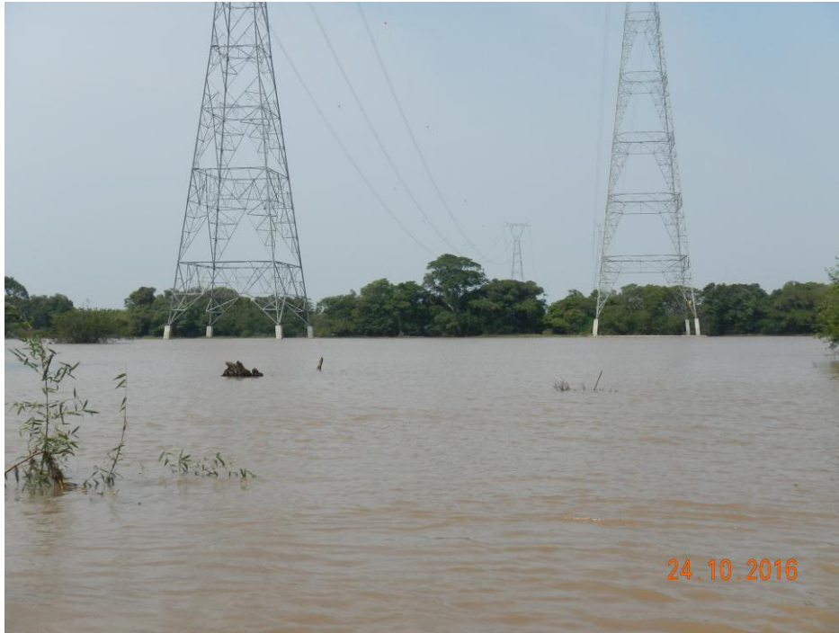
Imagem 11 – Observa-se as torres já construídas e a enchente na ilha do Araújo, nível d'água 4,82m.
