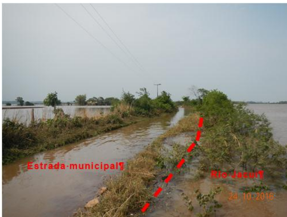
Imagem 1 – Condições da estrada municipal em outubro de 2016, mês de enchente no rio Jacuí. O nível da água em 24/10/2016 era de 4,82m
