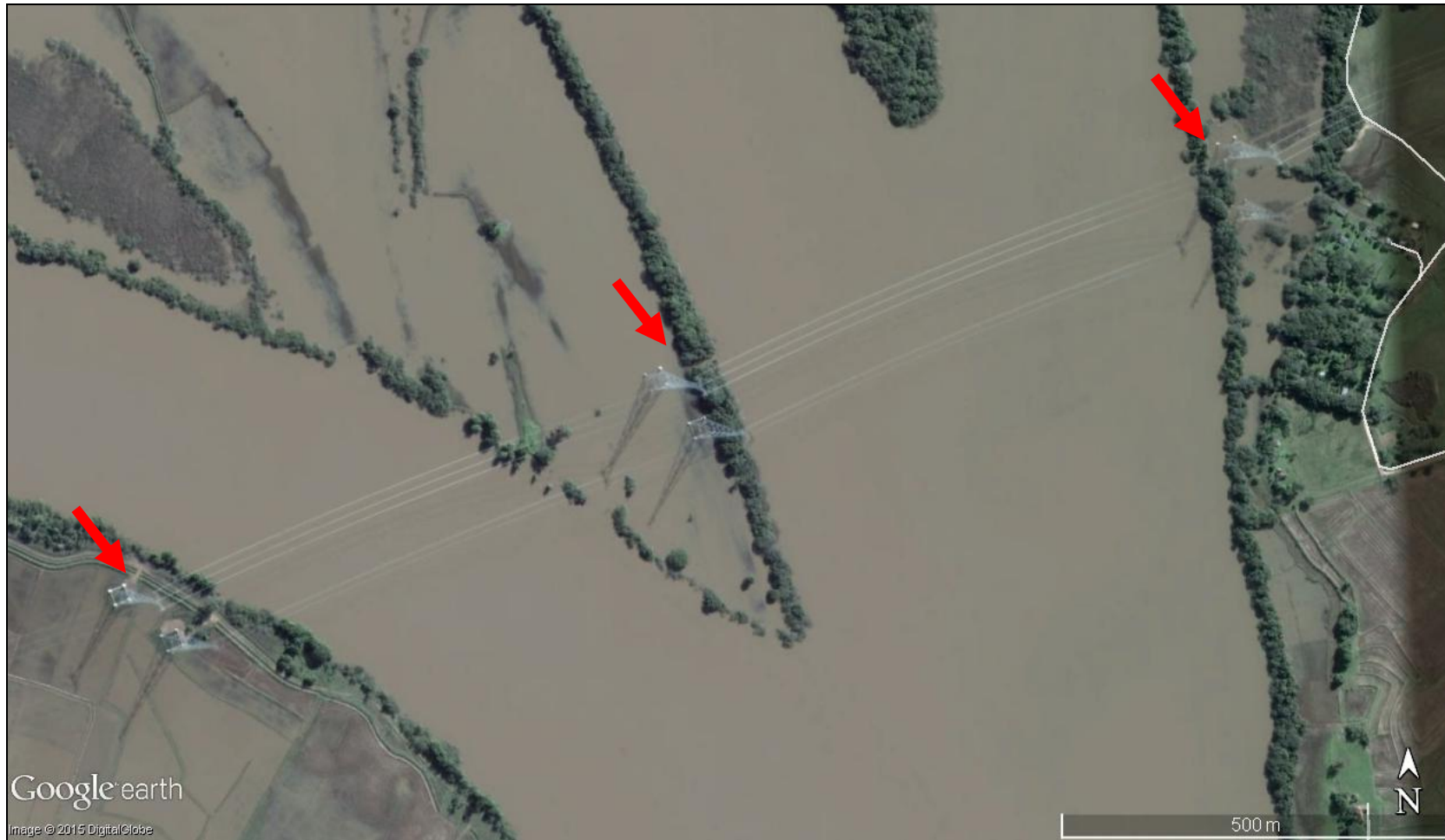
Imagem 12 – Observa-se através dessa imagem do Google Earth as torres já construídas nas proximidades das margens.
