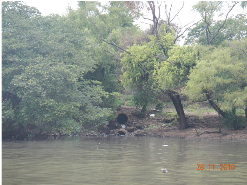
Imagem 17 – Um dos pontos de lançamento de efluente doméstico ao longo do trecho de concessão da SOMAR no rio Jacuí
