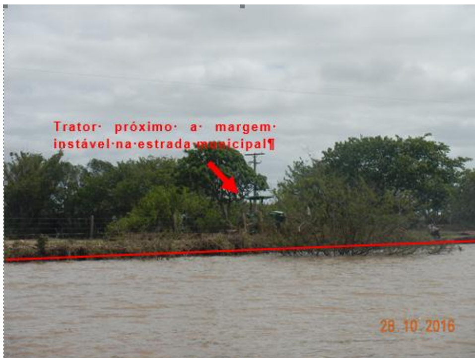
Imagem 2 – Maquinário agrícola nas proximidades da estrada municipal no dia 28/10/2016 quando o nível da água era de 4,06m
