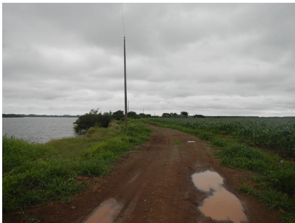
Imagem 3 – Estrada municipal localizada no limite do talude marginal
