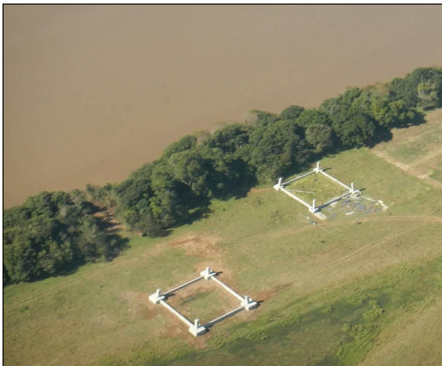
Imagem 9 – Construção das bases das torres de alta tensão na Ilha do Araújo, em 2013. Observa-se a proximidade das torres da margem esquerda da ilha.
