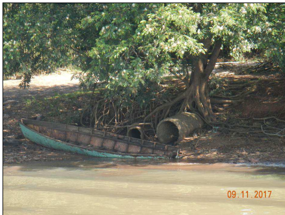
Imagem 14 – Um dos pontos de lançamento de efluente doméstico ao longo do trecho de concessão da SOMAR no rio Jacuí
