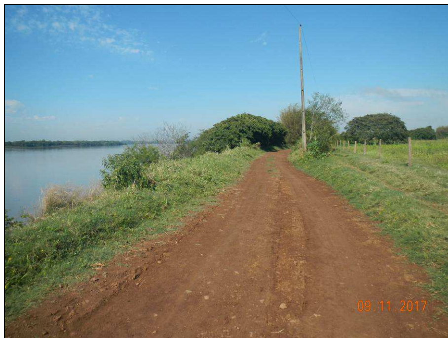
Imagem 5– Estrada municipal localizada no limite do talude marginal
