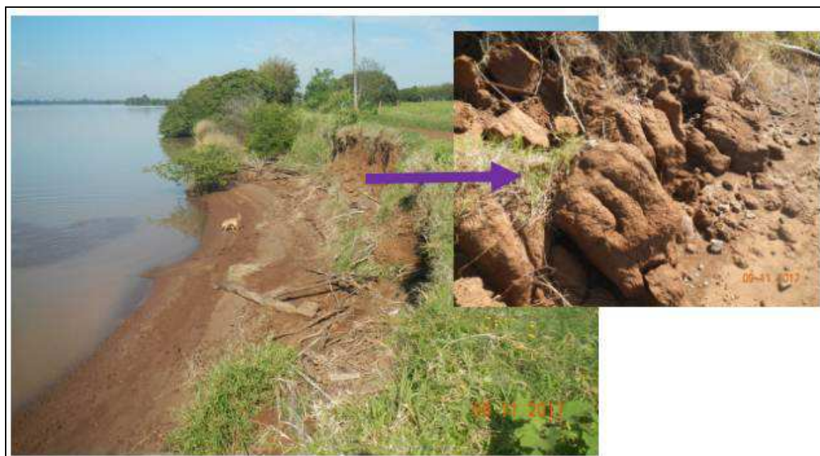
Imagem 7 – Demonstração do processo erosivo ativo que existe nessa área
