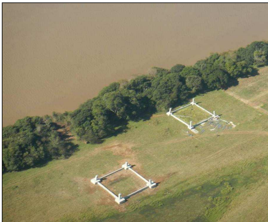
Imagem 10 – Construção das bases das torres de alta tensão na Ilha do Araújo, em 2013. Observa-se a proximidade das torres da margem esquerda da ilha.
