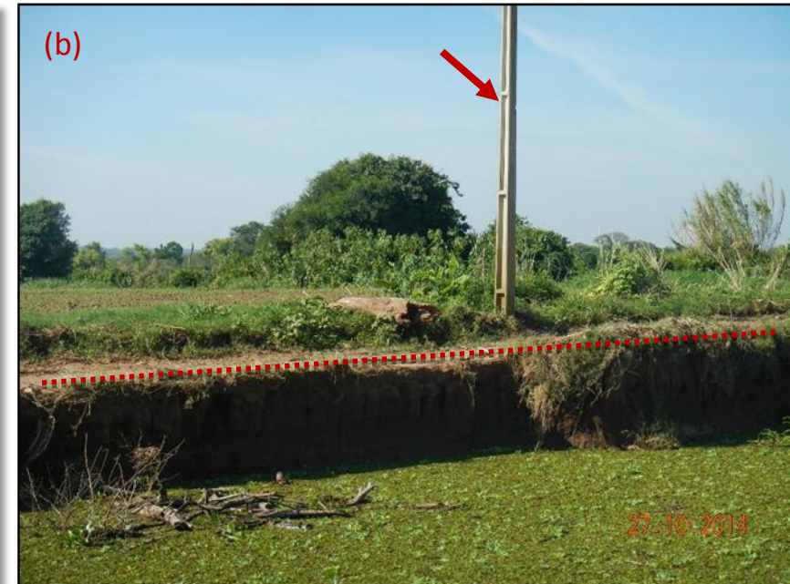
Figuras 7(a) e 7(b): Ação erosiva nos taludes em função do regime de enchente do rio na Estrada do Caloni.
