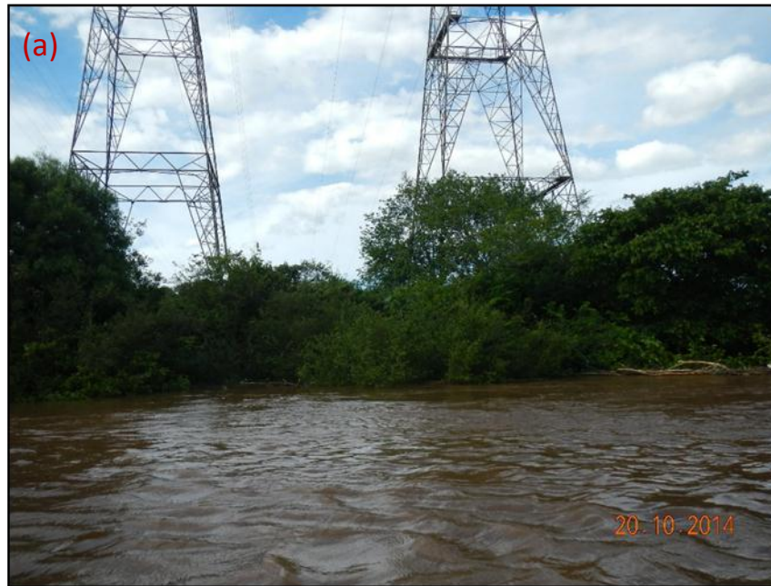
Figuras 2(a) e 2(b): Base das torres de Linha de Transmissão submersa localizada no pontal da Ilha das Cabras. No mesmo local, é visível o acúmulo de sedimentos arrastados pela corrente, incluindo restos mortais de um animal.
