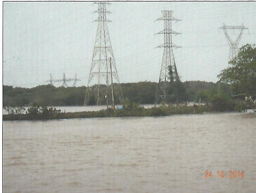
Foto 7 – Vista das torres localizadas na ilha das Cabras, margem direita, sentido norte-sul, 24/10/2016, nível d'água 4,82 m. Observa-se que as fundações das torres estão completamente submersas.
