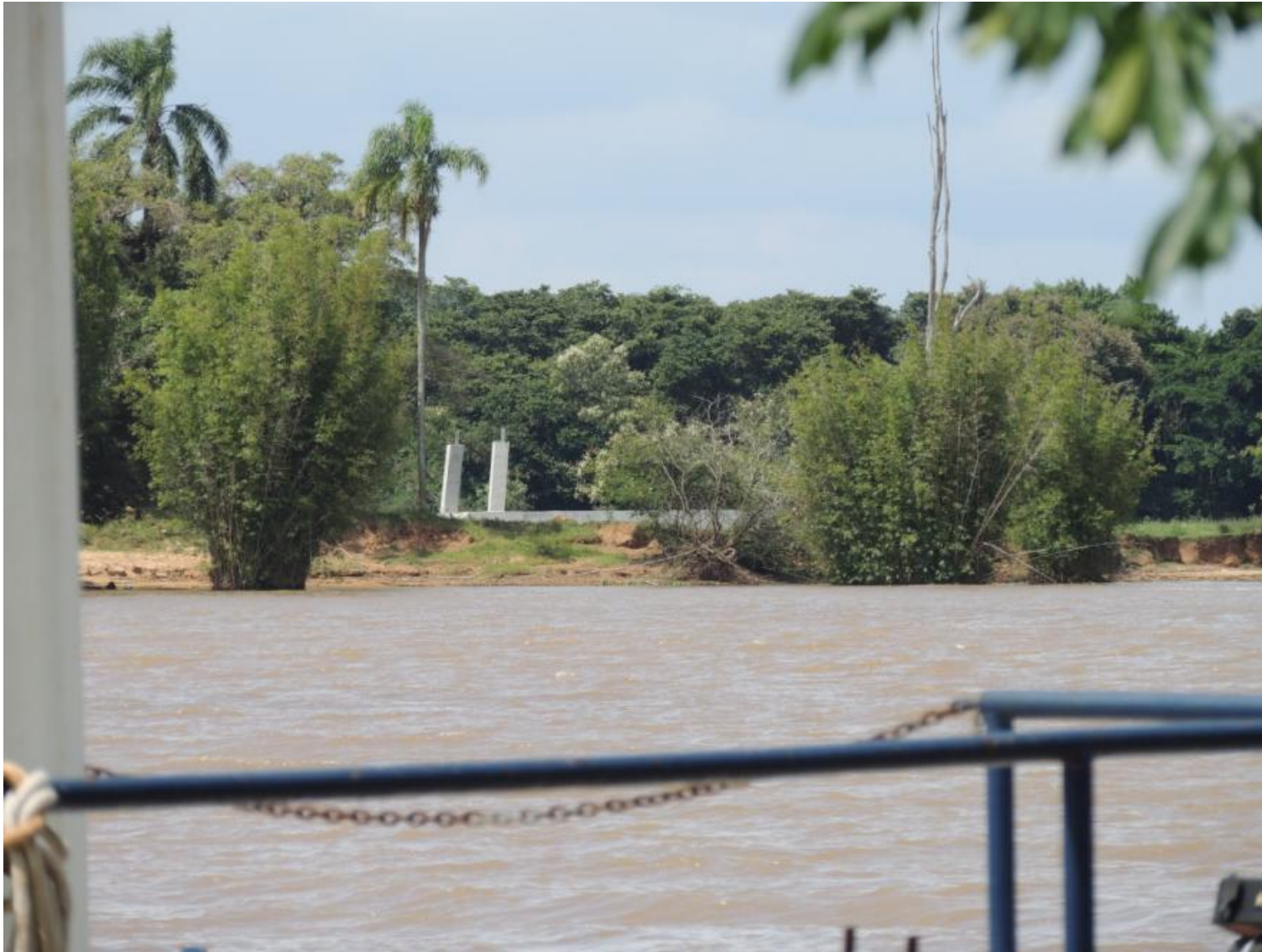
Imagem 17 – Detalhe de uma das estruturas de uma torre já concluída na Ilha do Araújo.
