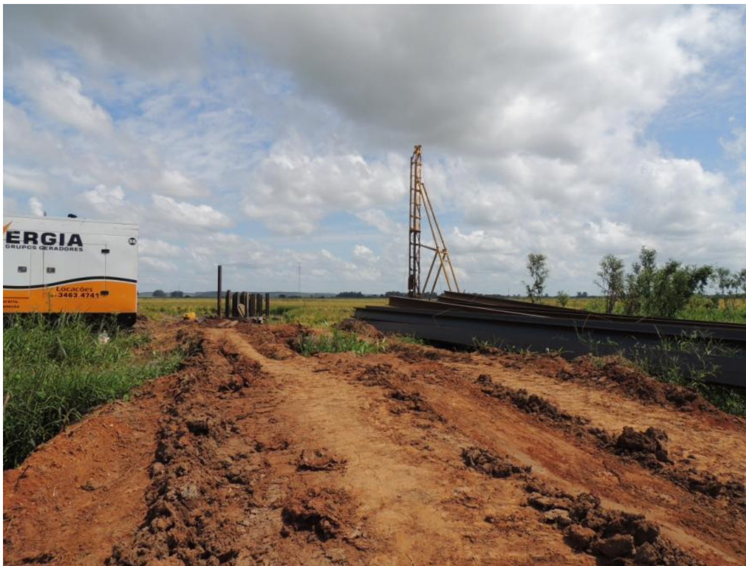
Imagem 14 – Detalhe da ponte sob o canal de irrigação.
