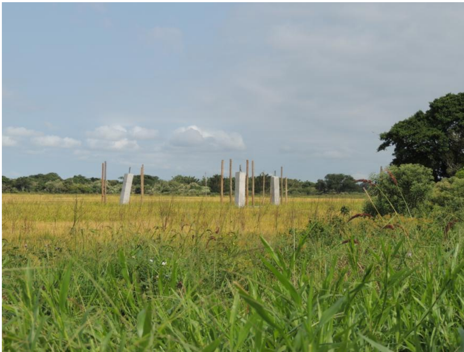
Imagem 03 – Vista da estrutura de uma das torres em meio à lavoura de arroz, na Fazenda São José.
