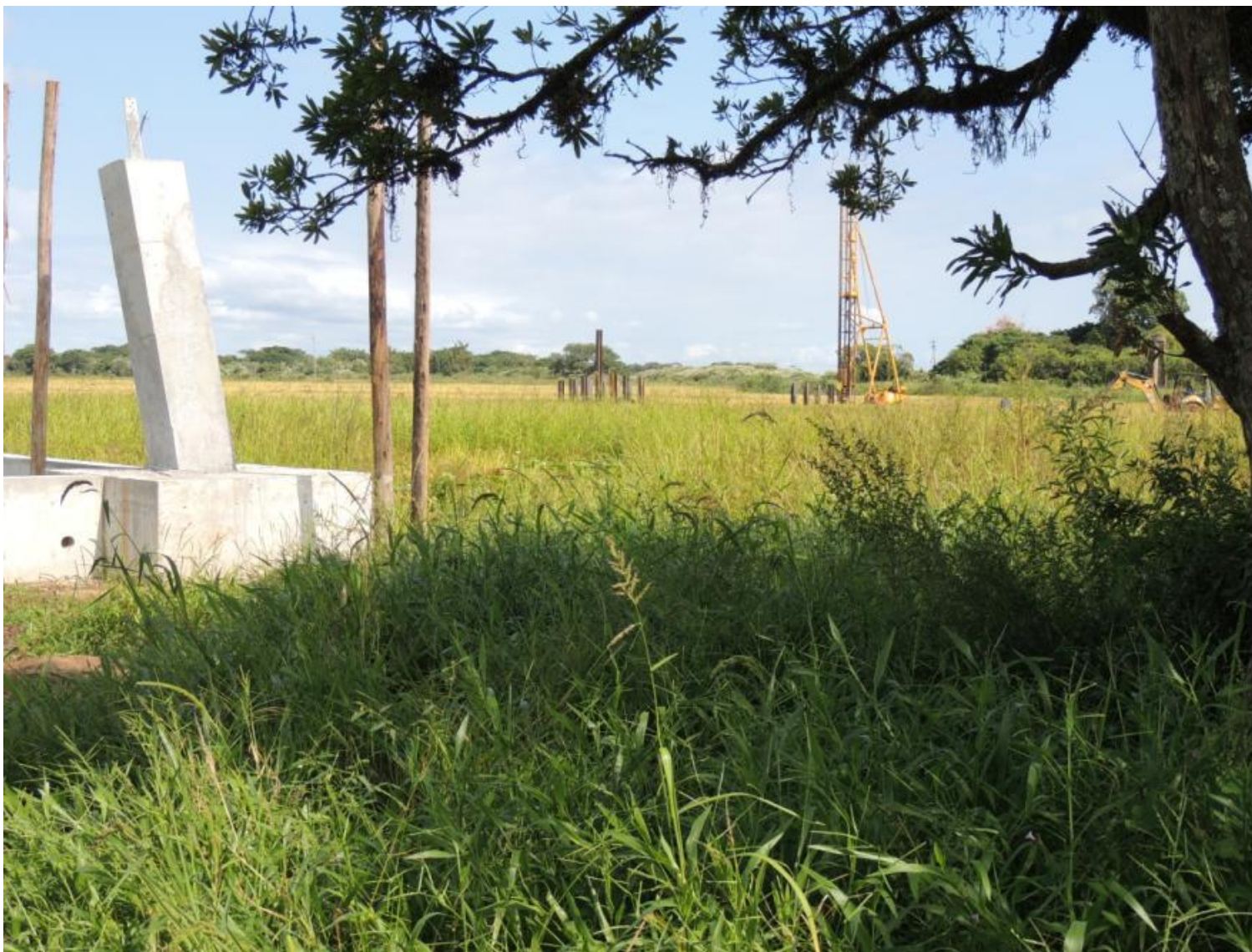
Imagem 09 – Detalhe à esquerda da estrutura concluída e ao fundo a construção da base de outra torre.
