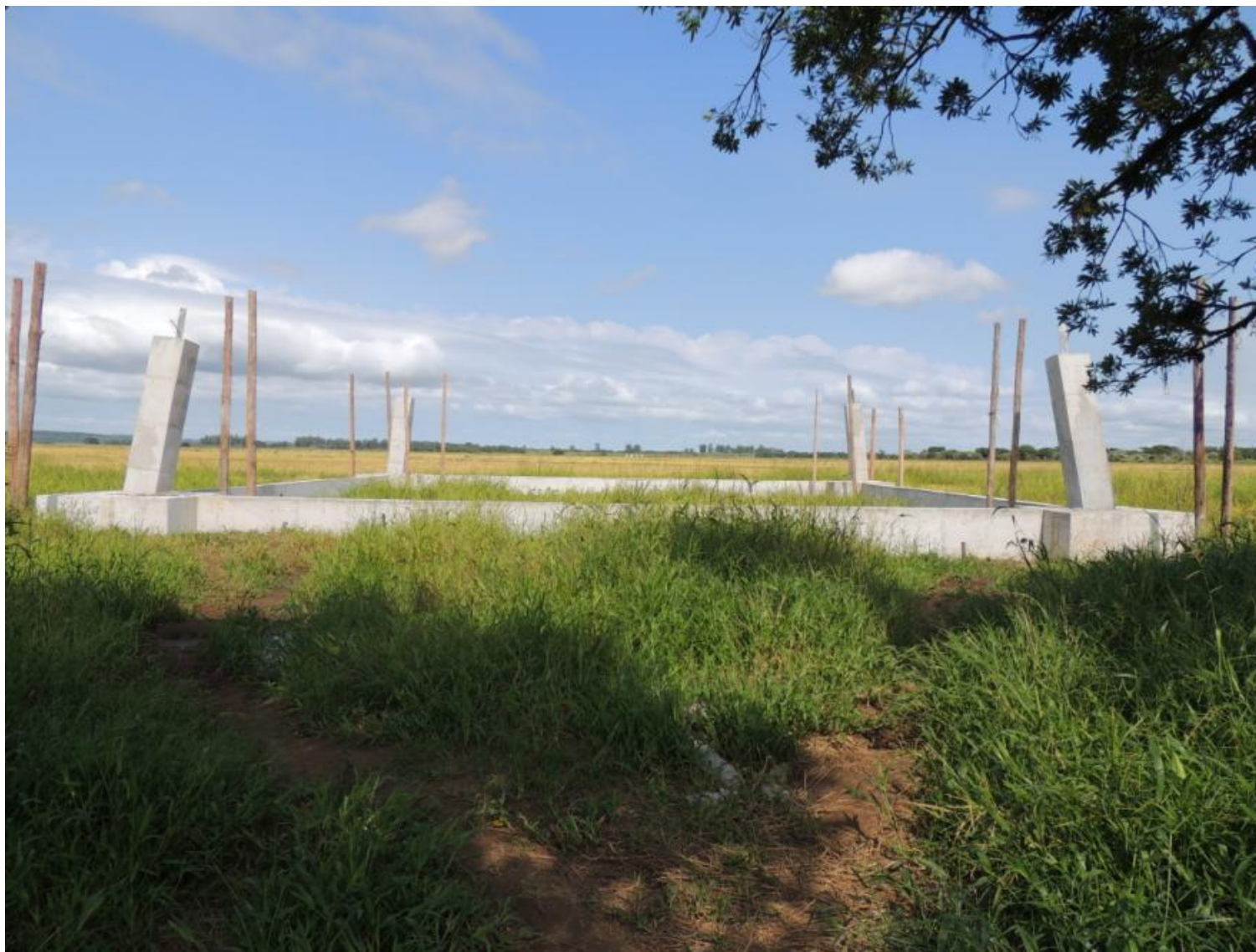
Imagem 04 – Detalhe da estrutura de uma das torres da Linha de Transmissão.
