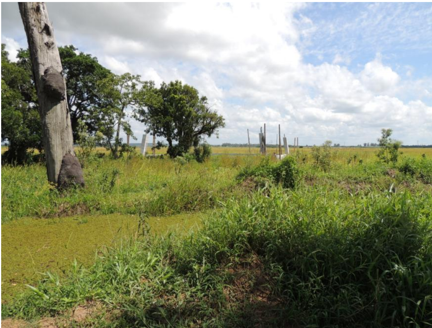
Imagem 02 – Detalhe da estrutura construída do lado direito do canal de irrigação.
