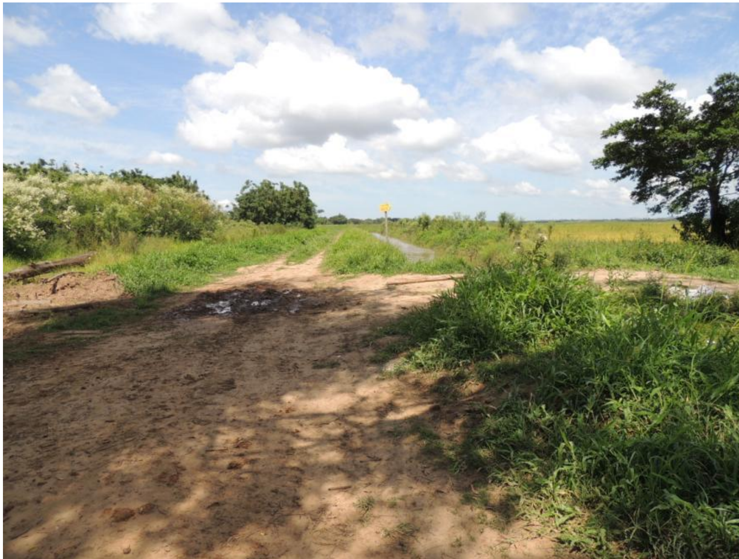
Imagem 01 – Local decapado utilizado para manobra e depósito de materiais e máquinas.
