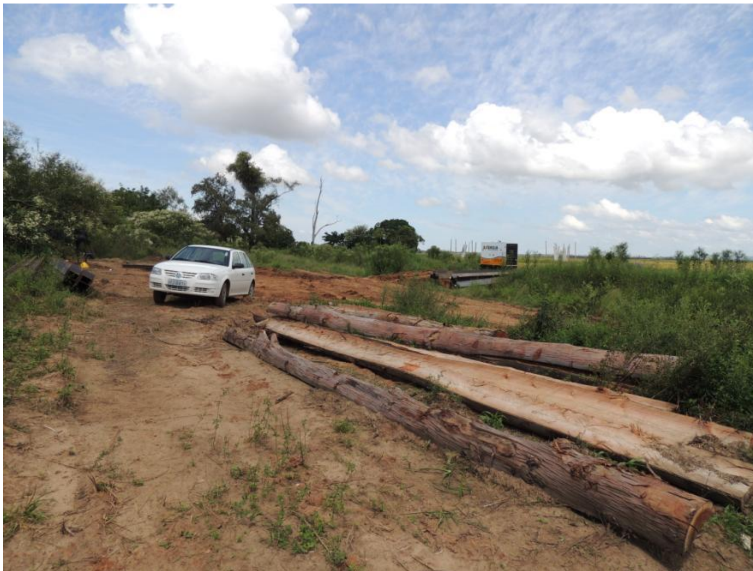
Imagem 15 – Detalhe das toras a serem utilizadas na obra.
