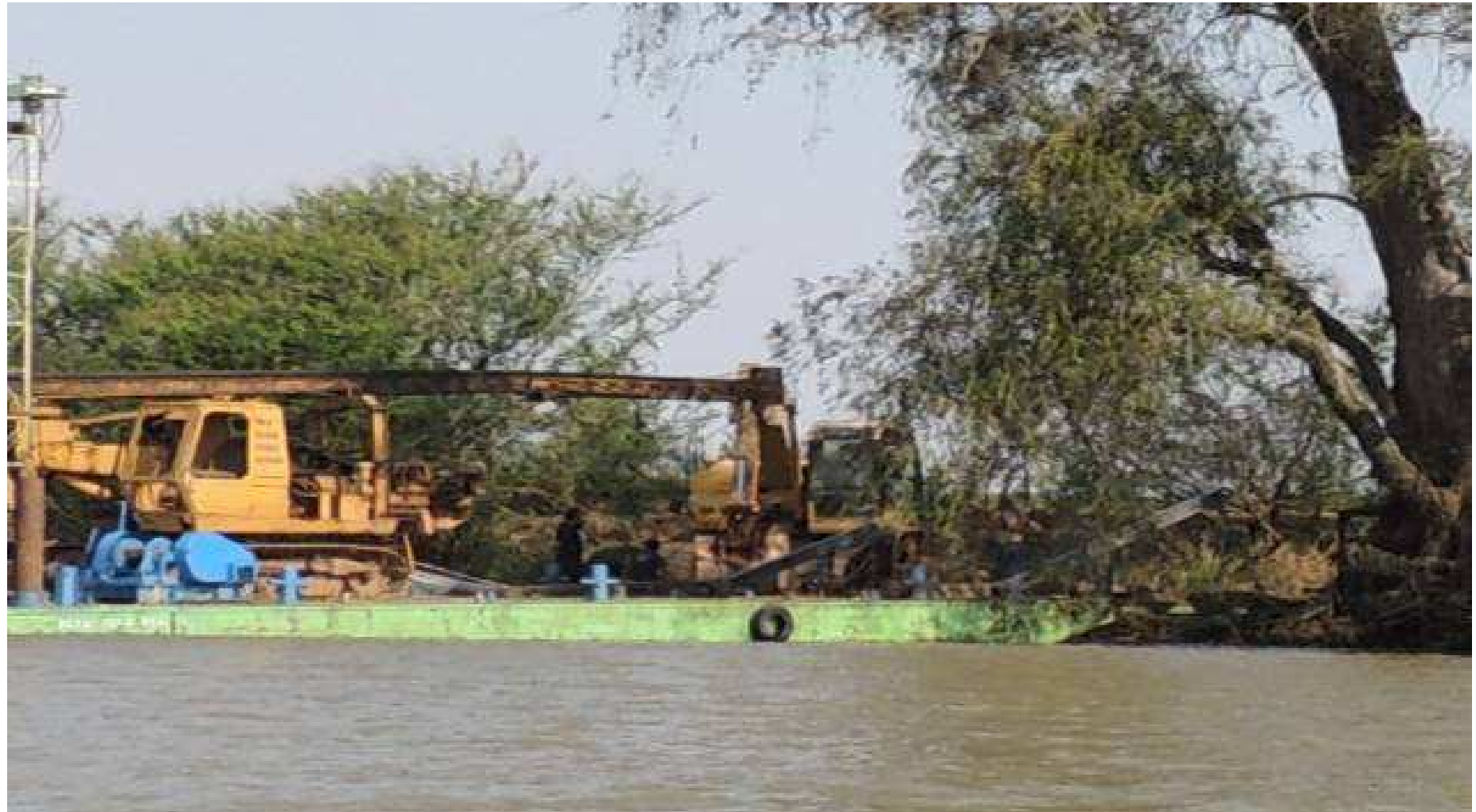
Imagem 06 – Fluxo intenso. Na margem, escavadeira espera o embarque.
