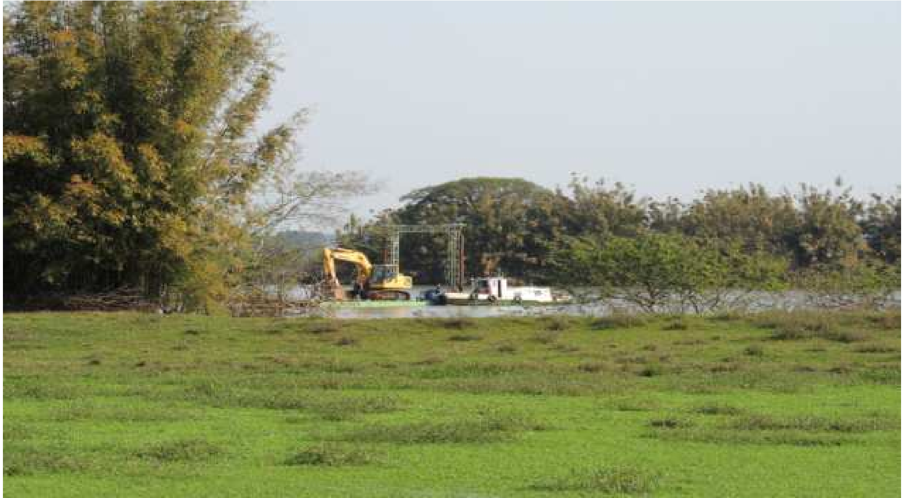
Imagem 14 – Chegada de escavadeira na ilha. Onde foram constatadas novas colisões nas taquareiras.
