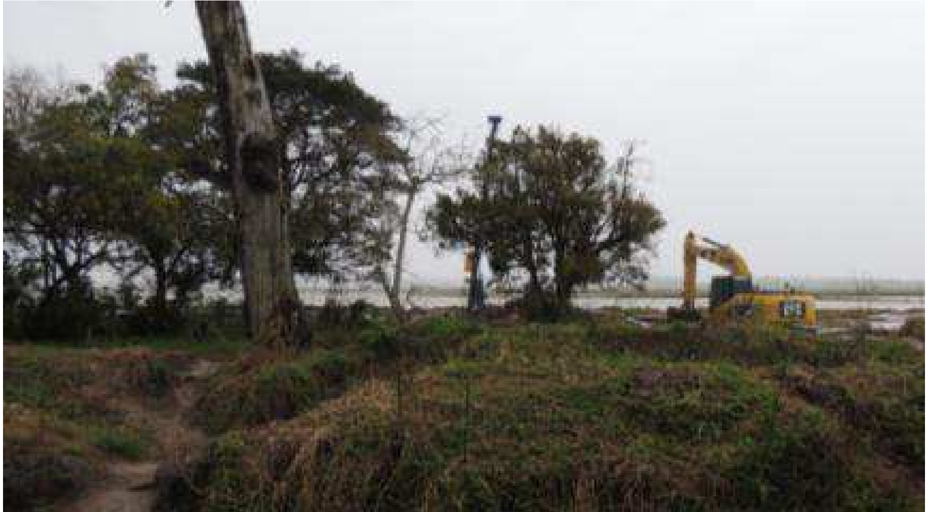
Imagem 04 - Fundações da torre de travessia, a aproximadamente 50 m.da margem. Registro em 23-08-2013.
