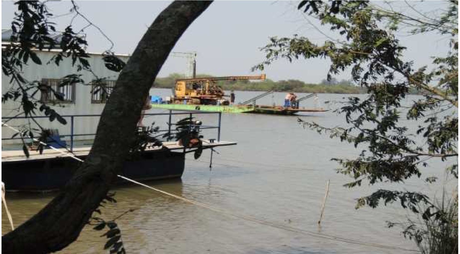
Imagem 05 – Chegada da balsa com maquinário no ponto 15.
