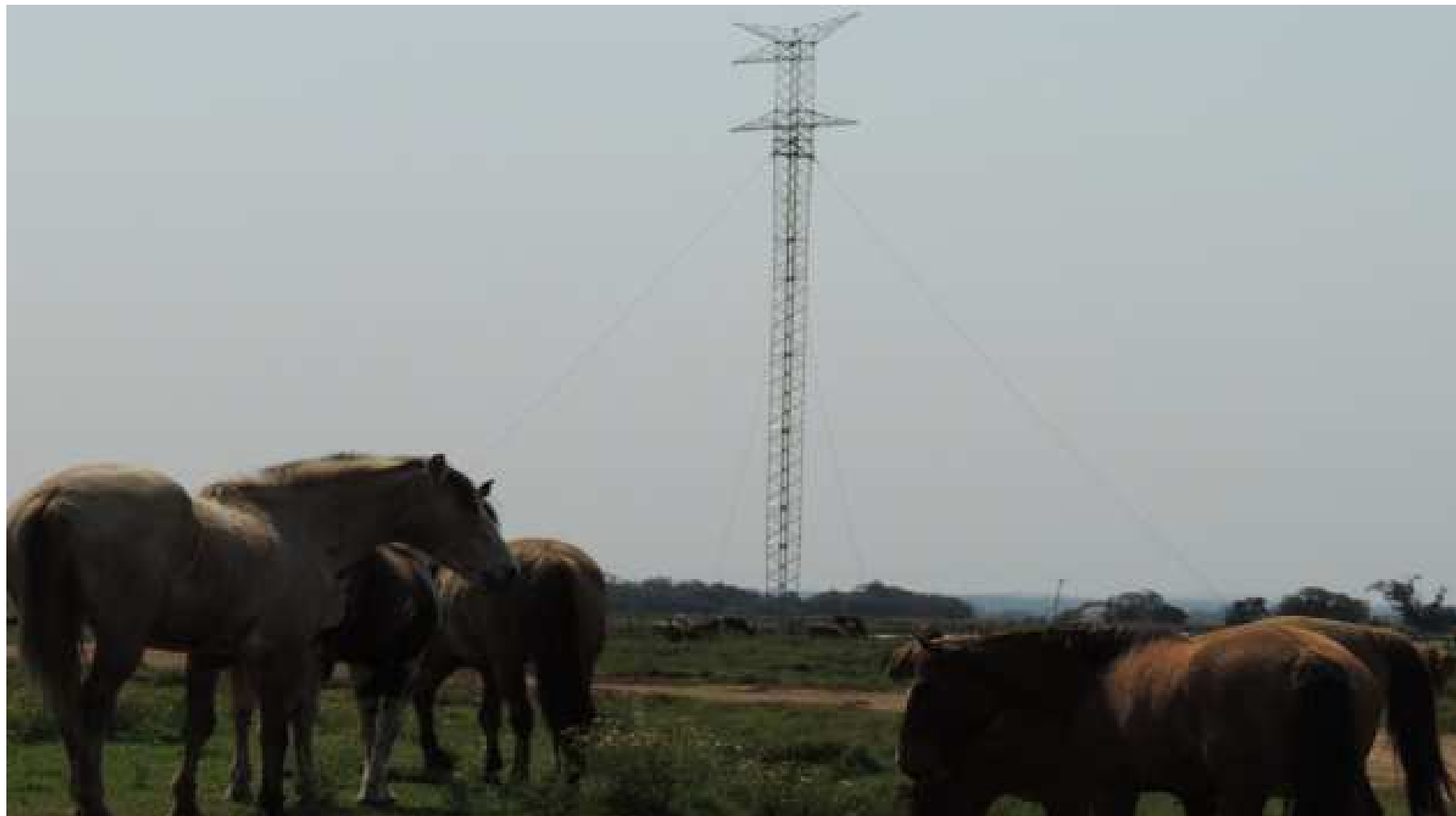
Imagem 02 – Primeira torre de alinhamento já instalada.
