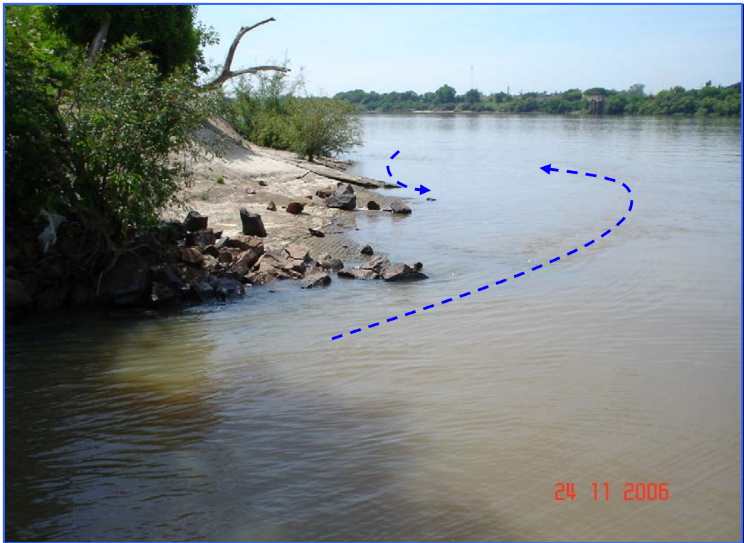
Foto 25 – Aspectos gerais das primeiras placas de argamassa protegidas com aterro de enrocamento – as setas indicam as condições da correnteza sofrendo desvio (deflexão). Ao fundo, no 1º trecho instável, são visíveis correntes de retorno, que formam redemoinhos e turbilhionamento das águas.
