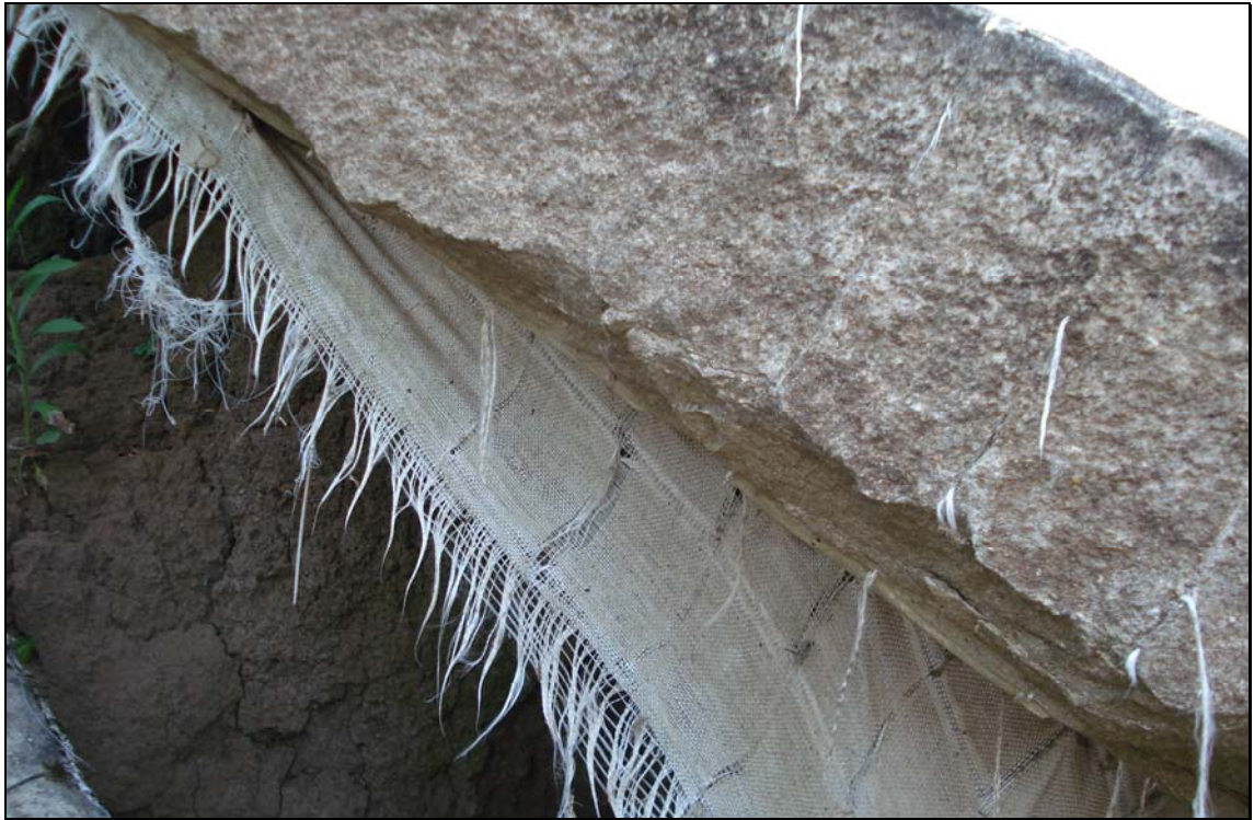
Foto 8 – Detalhes de uma placa de argamassa, do geossintético tecido e dos fios na direção perpendicular ao plano do talude, que deram a conformação das geofomas
