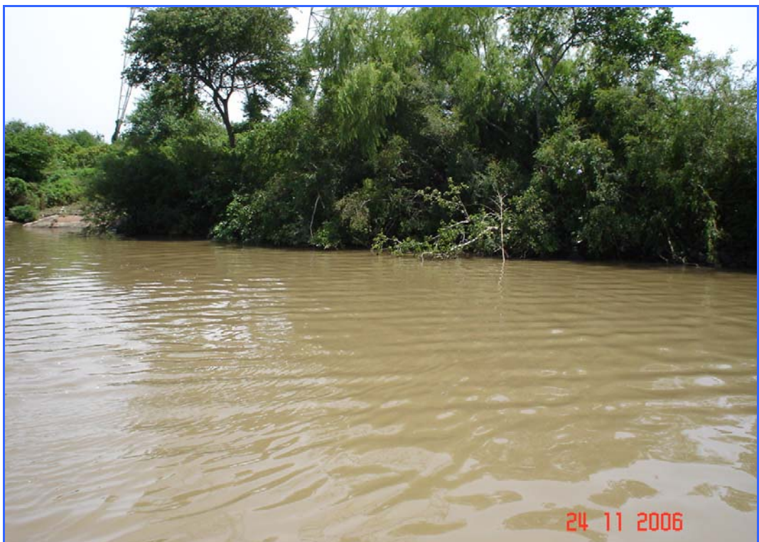
Foto 26 – Aspectos gerais do trecho final das soluções de estabilização e proteção da margem direita do Pontal da Ilha – no emaranhado da vegetação
