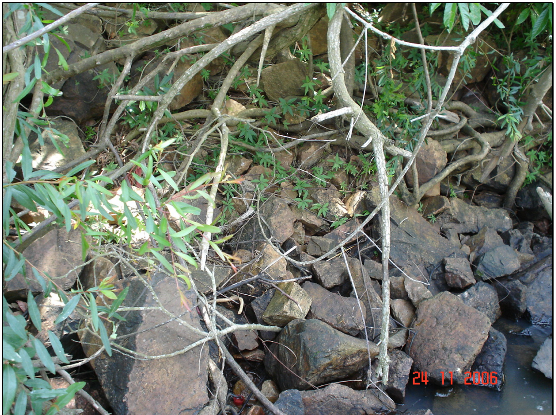
Foto 4 – Detalhes do aterro de enrocamento do trecho final das soluções de estabilização da margem direita da Ilha das Cabras – observar que a vegetação ribeirinha está fixando o seu sistema radicular nos vazios dos blocos rochosos
