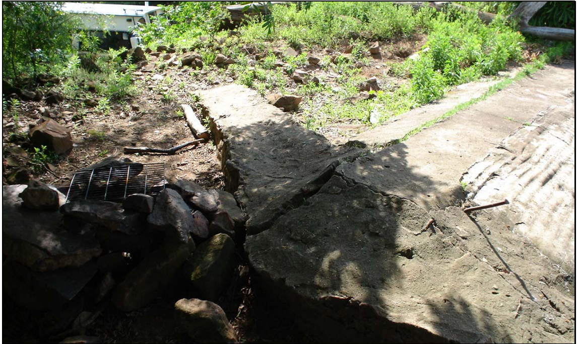
Foto 3 – Detalhes do coroamento da primeira placa de argamassa e do diafragma de argamassa ciclópica – este local está em excelentes condições de estabilidade.
