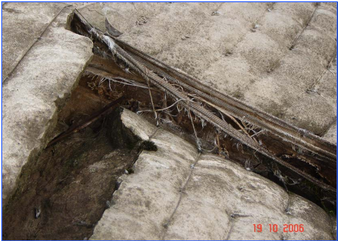
Foto 12 – Detalhes de uma emenda de geoformas que funcionam como juntas de contração.
