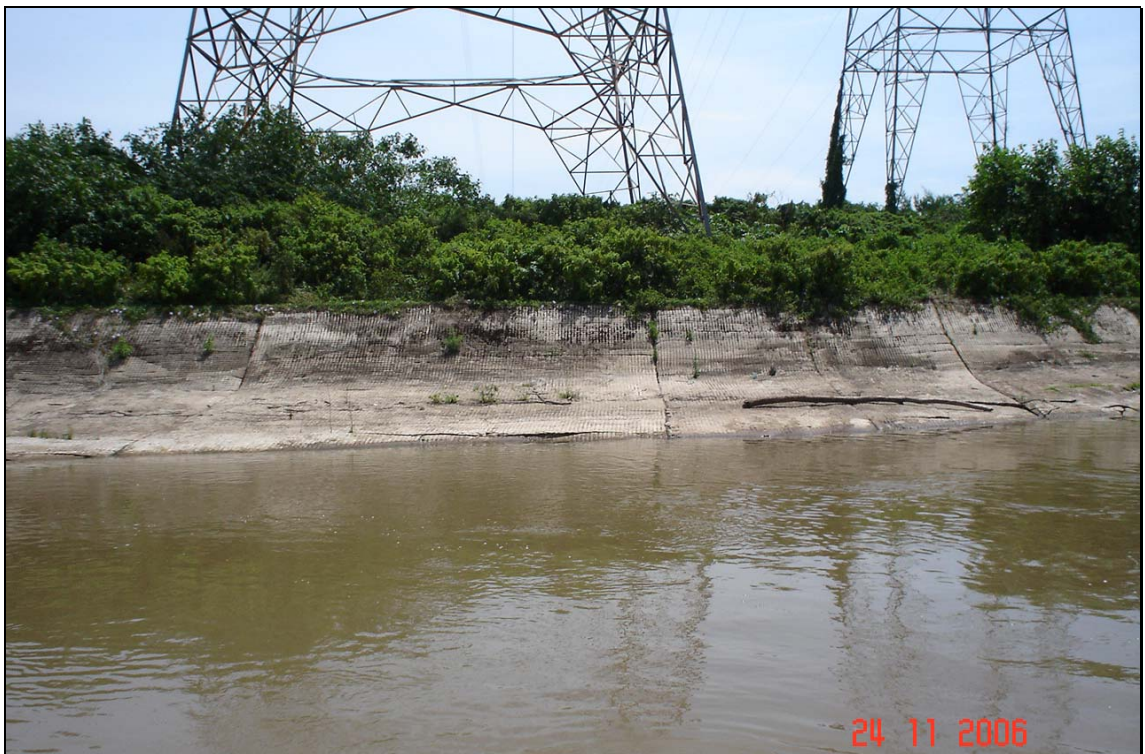
Foto 9 – Vista geral das placas de estabilização e proteção do talude da margem direita do Pontal da Ilha – ao fundo vê-se as torres de alta tensão. Este trecho se mostra com razoáveis a boas condições de estabilidade, o que está favorecendo a manutenção da estabilidade das fundações da Torre T2 (Foto 6).
