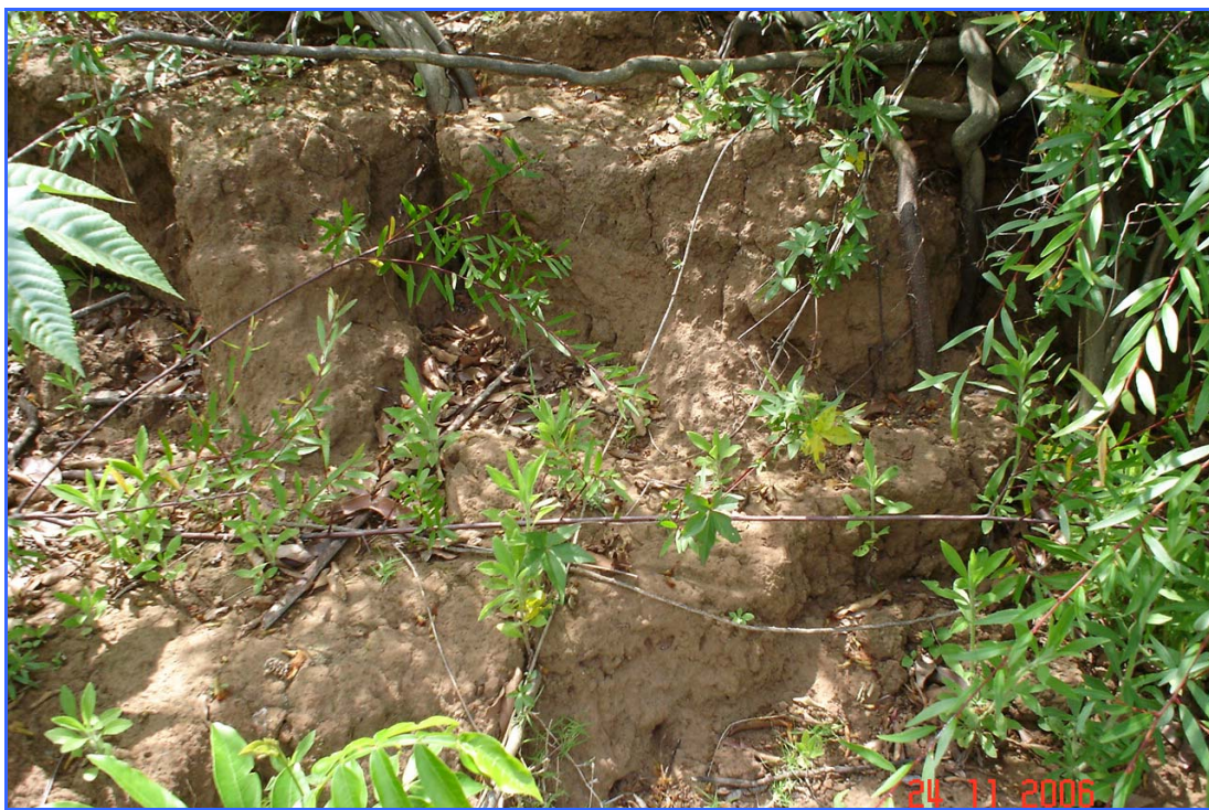
Foto 23 – Detalhes dos solos areno-argilosos que ocorrem na margem direita do Pontal da Ilha – esta foto é representativa do 3º trecho de placas instabilizadas.
