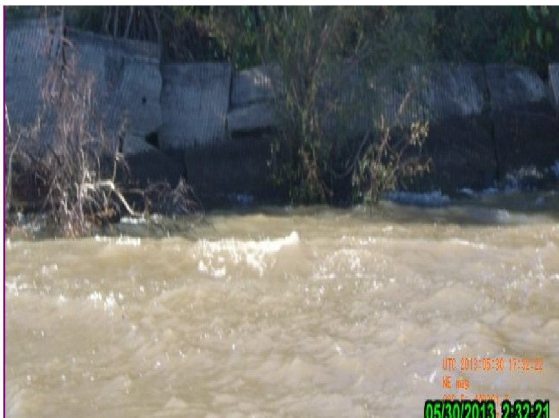
FOTO 7. Detalhe da situação da parede de proteção.
