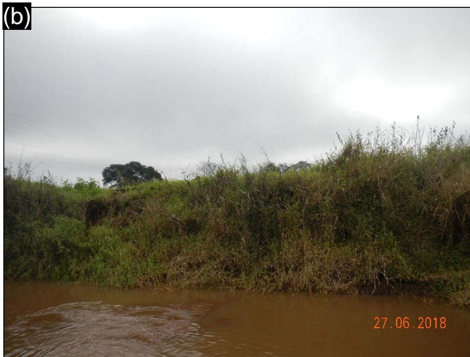
Figura 18: (a) Imagem detalhando o marco de concreto na campanha de junho/2018. (b) Imagem no sentido Sul para Norte das condições do talude.
