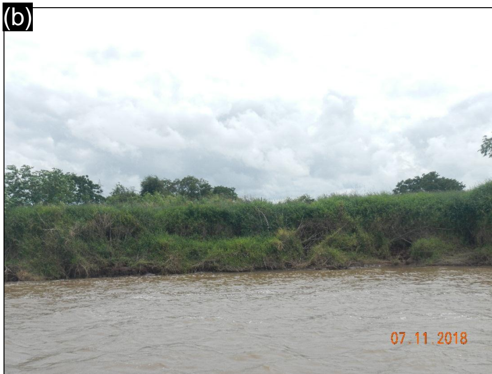
Figura 19ab: (a) Imagem detalhando o marco de concreto durante inspeção em novembro/2018. (b) Imagem no sentido Sul para Norte das condições do talude.
