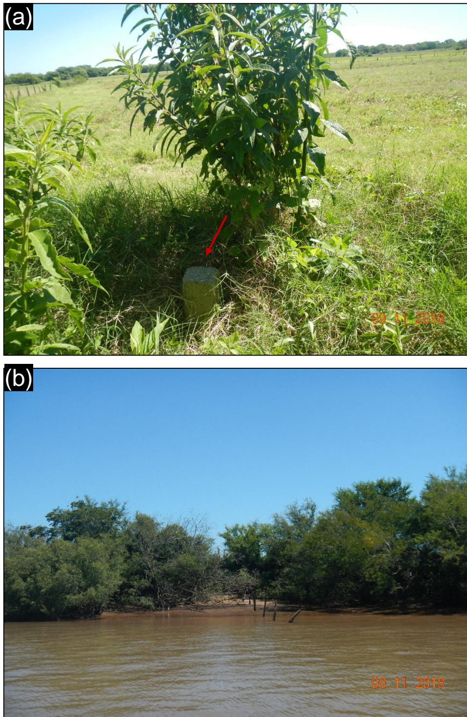
Figura 44: (a) Localização do marco e seu entorno. (b) Vista geral do talude monitorado e da vegetação arbustiva na margem. Em novembro/2018 faixa de areia ficou emersa devido ao baixo nível do rio.
