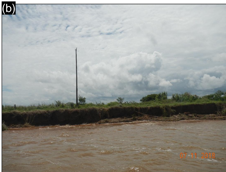
Figura 22: (a) Imagem ilustra os blocos de solo que se desprenderam do talude, fato que comprova o alto índice de erosão do período monitorado. (b) Imagem geral do ponto de monitoramento.
