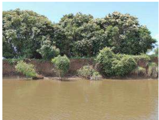
Figura 25: Detalhe da margem na area de plantio observando-se exemplares tombados, evidenciando o avanço da erosão.
