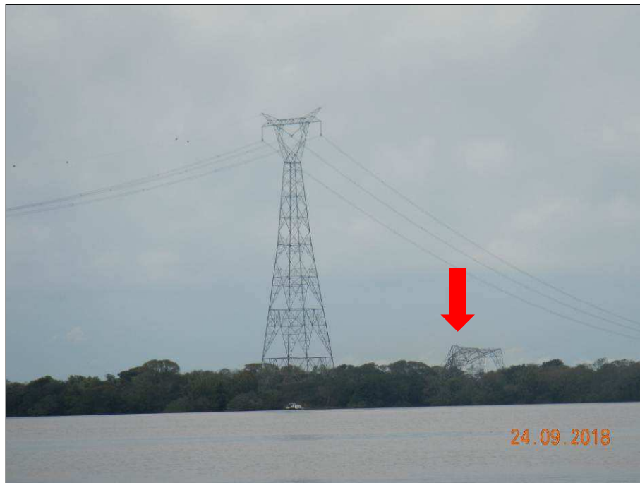
Foto 16 – Torre caída na margem de Triunfo
