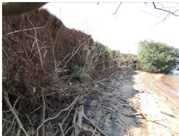
Figura 39: Detalhe da conformação do talude da margem, no outono de 2019.
