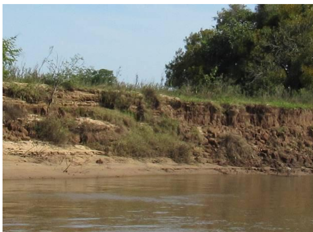
Figura 54: Segmento da margem sem vegetação protetora, observando-se erosão do barranco, na primavera de 2019.
