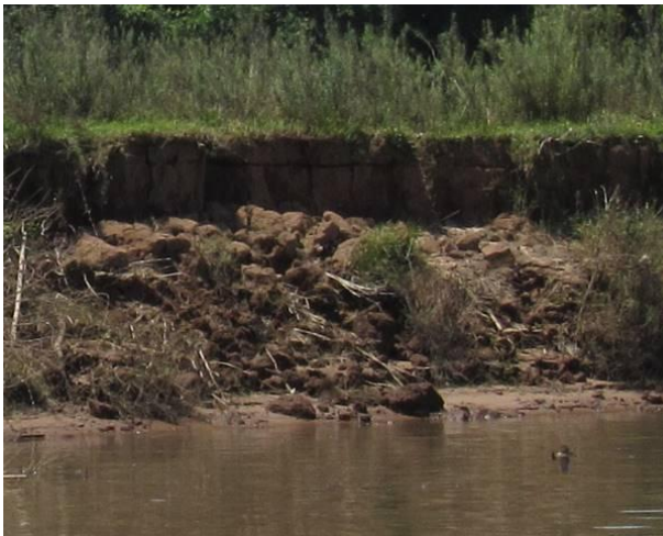
Figura 22: Flagrante do desmoronamento do talude da margem, em área sem proteção de vegetação, no outono de 2019.
