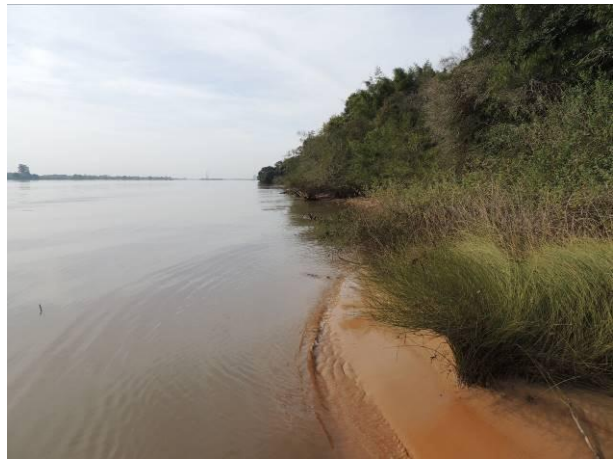
Figura 13: Margem apresentando estabilidade do talude, no outono de 2019.
