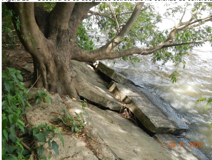
Figura 25 – Observa-se os desgastes estruturais no colchão de concreto.
