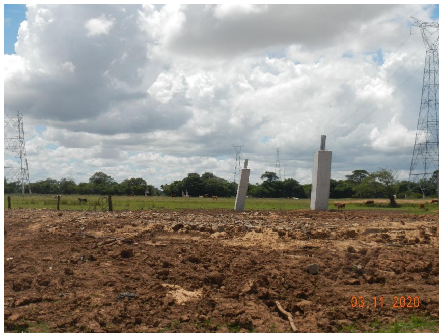
Figura 20 – Registro de 03/11/2020, onde ocorria a instalação das novas torres de transmissão na ilha.
