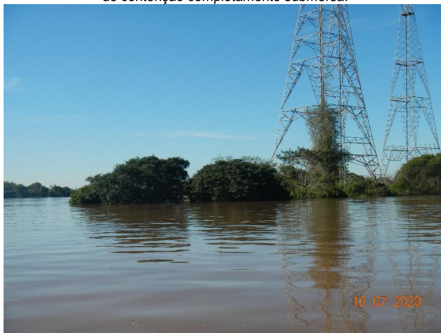
Figura 23 – Observa-se a enchente na ilha das Cabras, nível d'água 6,26m, em 10/07/2020. A estrutura de contenção completamente submersa.
