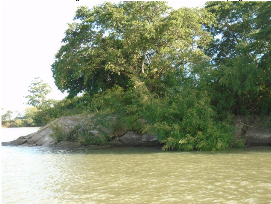
Figura 23 – Observa-se os desgastes estruturais no colchão de concreto (Registro em 29/12/21).
