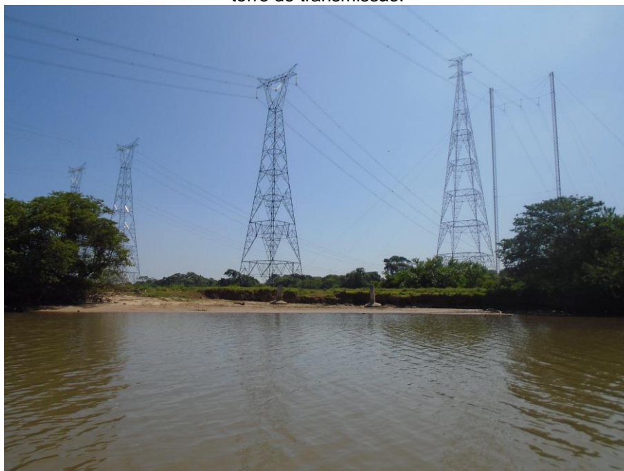
Figura 19 – Registro de 02 de novembro de 2021 realizado pela fiscalização da SOMAR, no acompanhamento das margens, onde é possível observar a distância mínima do talude marginal até a torre de transmissão.
