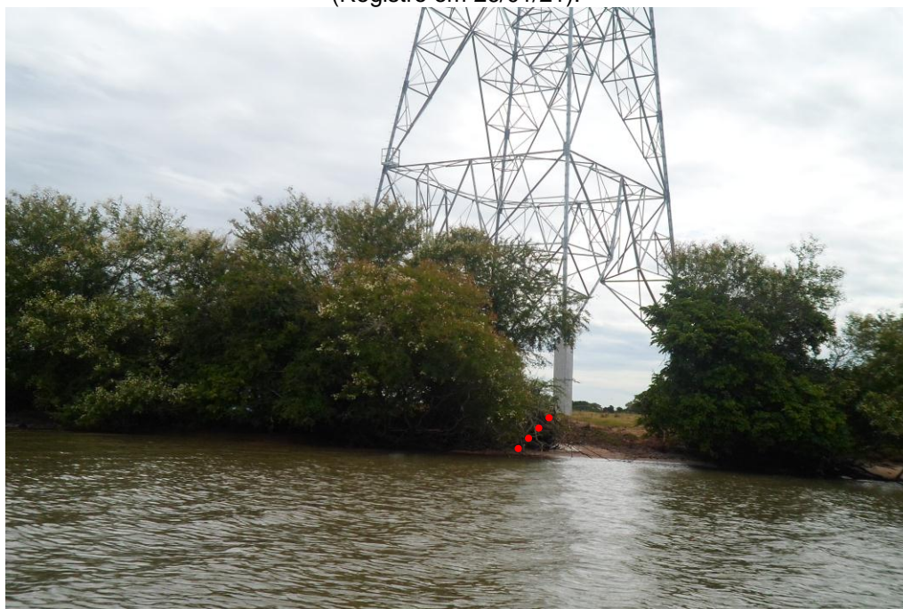
Figura 19 – Registro de 02 de novembro de 2021 realizado pela fiscalização da SOMAR, no acompanhamento das margens, onde é possível observar a distância mínima do talude marginal até a torre de transmissão.
