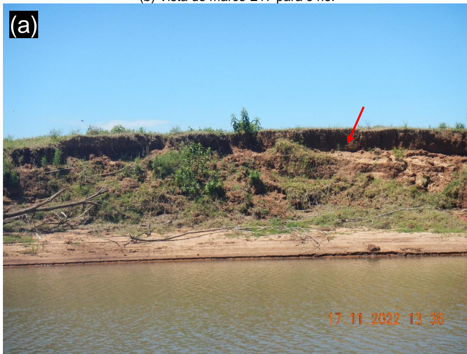
Figura 41 – (a) Condição do talude marginal onde está localizado o marco, indicado com a seta, possível perceber a falta de vegetação ciliar, aumentando o risco de solapamento dos taludes. (b) Vista do marco E17 para o rio.
