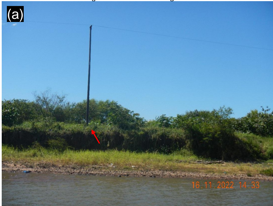
Figura 27 – (a) Vista do marco E10B, percebe-se talude exposto, sem presença de mata ciliar, sendo sucessível a erosão na região. (b) No local foi possível identificar presença de acampamento e fogueiras nos limites marginais.
