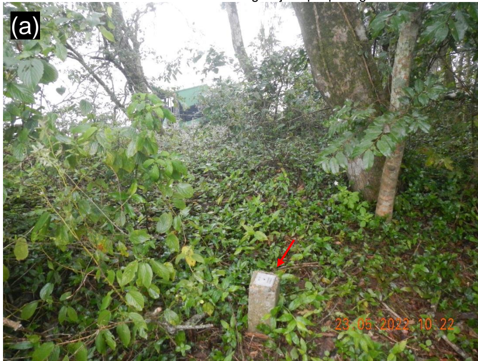
Figura 12 – (a) Vista do marco para o talude marginal. b) Vista geral da localização do marco, observa-se troncos cortados e a vegetação que protege os taludes.
