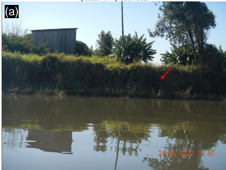
Figura 24 – (a) Imagem no sentido Sul-Norte do talude monitorado. (b) Imagem detalhando o entorno da área de monitoramento. Observa-se a estrada municipal no limite da margem do rio, que não possui APP preservada.
