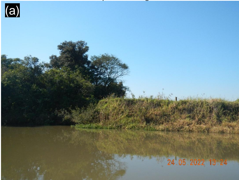
Figura 42 – (a) Vista geral do talude onde está localizado o marco E18D, presença de gramíneas, porém sem vegetação ciliar densa. (b) Vista geral da localização do marco. Observa-se que a área é intensamente utilizada para agricultura e pecuária em períodos intercalados, além de uma estrada vicinal próximo a margem.
