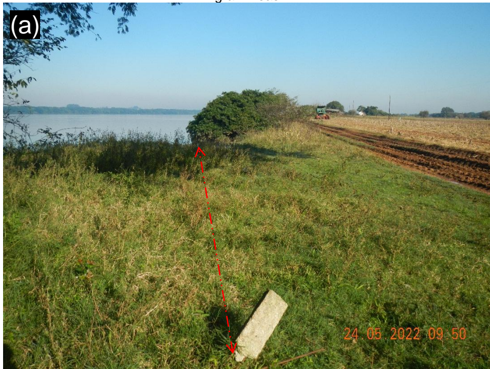
Figura 18 – (a) Marco E06B direção da medida em vertical, no local estava ocorrendo a preparação do solo. Observa-se também a falta de mata ciliar nos taludes marginais. (b) Vista do talude marginal, sentido Oeste da localização do marco, presença de vegetação ciliar composta apenas por gramíneas.
