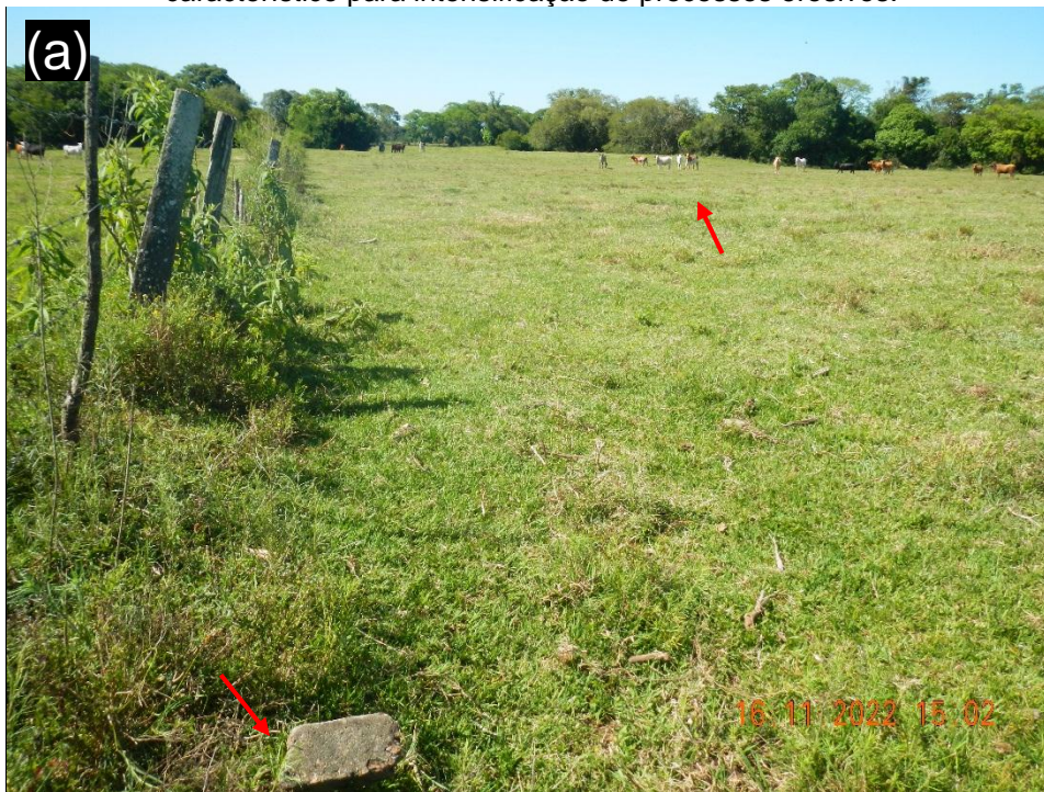
Figura 23 – (a) Vista do Marco E09 para o interior da ilha, presença de gado. (b) Observa-se na margem, a presença de abertura de uma vala devido ao pisoteamento do gado para dessedentação, característico para intensificação de processos erosivos.
