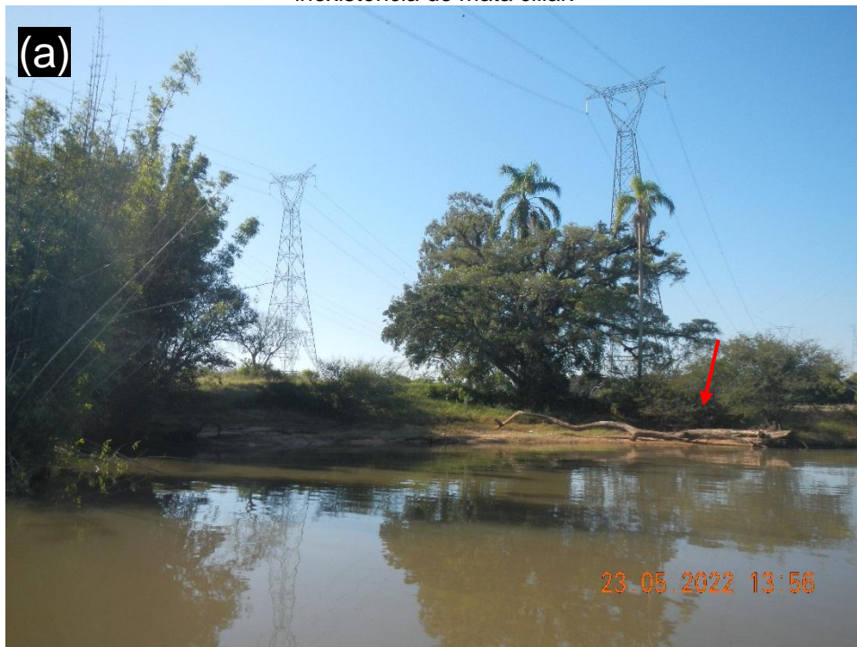
Figura 36 – (a) Talude marginal onde está localizado o marco monitorado, presença de exemplar arbóreo tombado e as torres de transmissão. (b) Imagem do marco E16 em sentido ao rio, observa a inexistência de mata ciliar.
