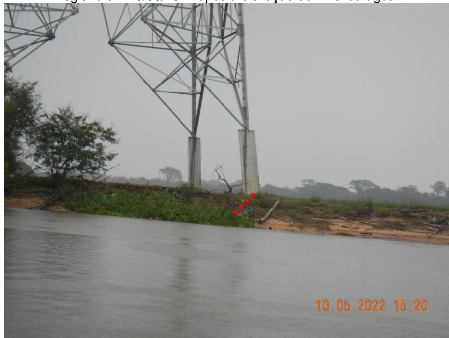
Figura 17 – Observa-se a pequena distância da base da estrutura em direção a margem do rio Jacuí, registro em 10/05/2022 após a elevação do nível da água.
