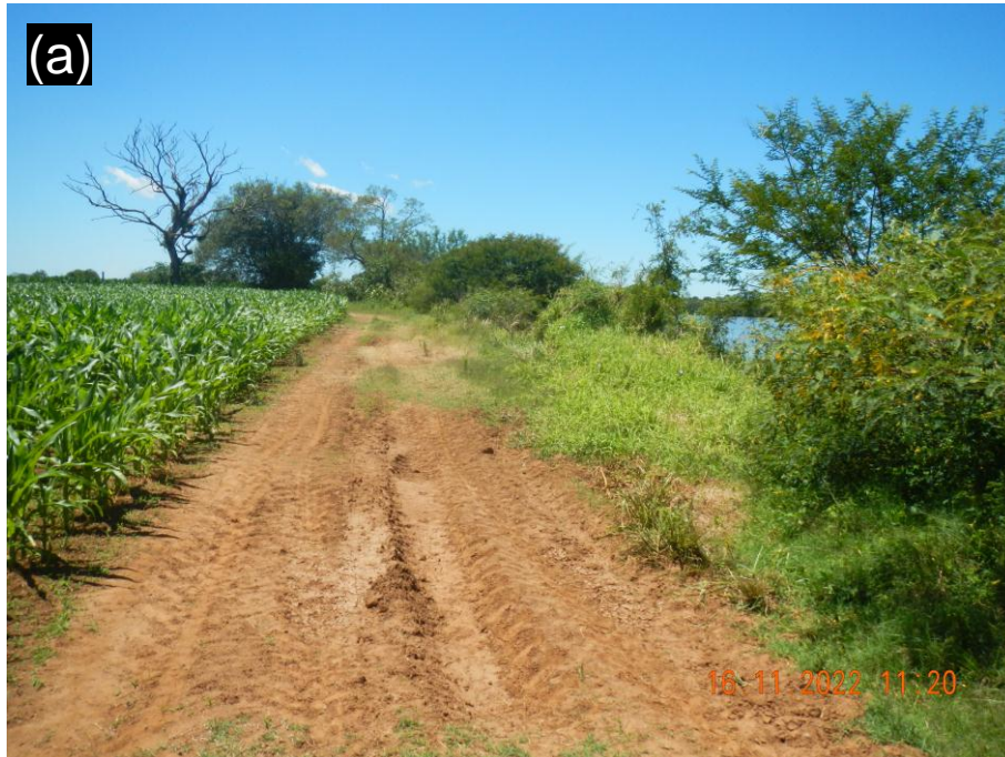
Figura 12ab – (a) Margem esquerda do rio Jacuí, Ilha da Paciência, presença de plantação e estrada vicinal em quase toda extensão monitorada. (a) Registro em 18/11/2022 no Marco E02A. (b) Registro em 18/11/2022 no Marco E06B.
