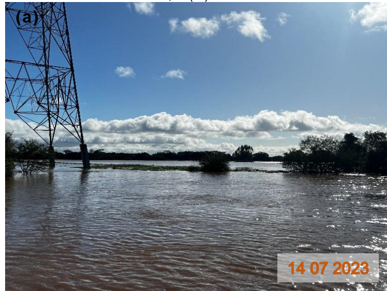
Figura 27 (a-f) – ilha do Araújo, margem direita – Coord. UTM do local ( datum SIRGAS2000): X (m): 454.509 ; Y (m): 6.687.462.
